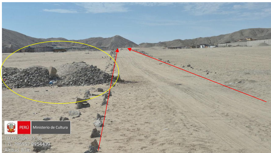
Imagen 01: vista a detalle del segmento del camino con alineamiento de piedra en ambos extremos, la misma que presenta cumulo de material de escombros encima de las piedras alineadas
