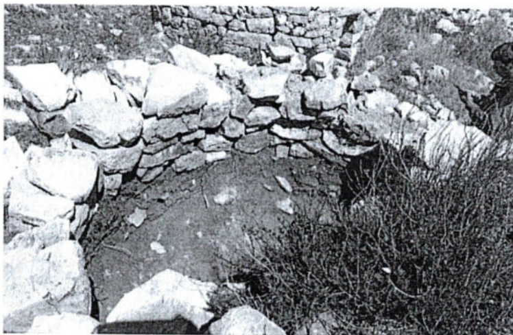
Foto.7: Vista de las estructuras arquitectónicas de planta circular de forma abovedado donde se realizó excavaciones y reconstrucción de muro. (inspección técnica 02/03/2026).
