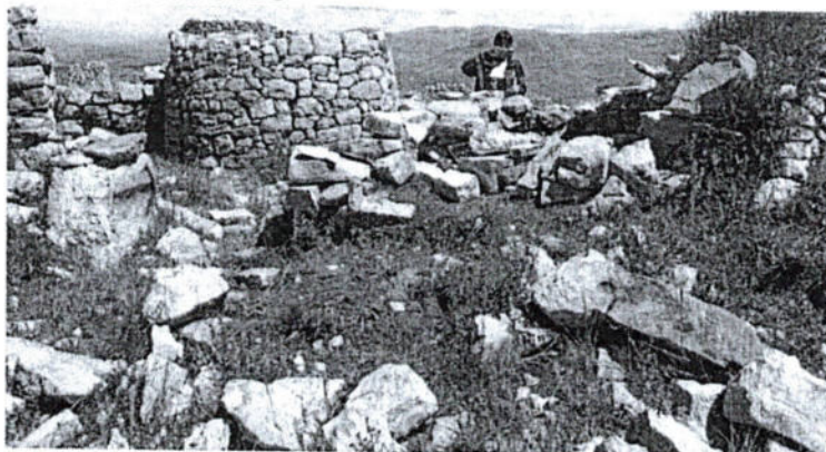
Foto.1: Vista de las estructuras arquitectónicas intervenidos sin autorización del ministerio de cultura y sin la supervisión de un especialista. (inspección técnica 02/03/2026).
