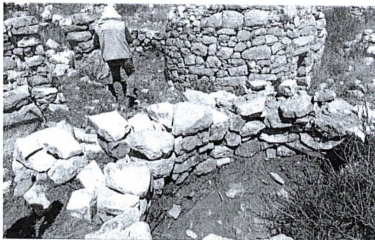
Foto.8: Vista de las estructuras arquitectónicas de planta circular de forma abovedado donde se realizó excavaciones y reconstrucción de muro. (inspección técnica 02/03/2026).
