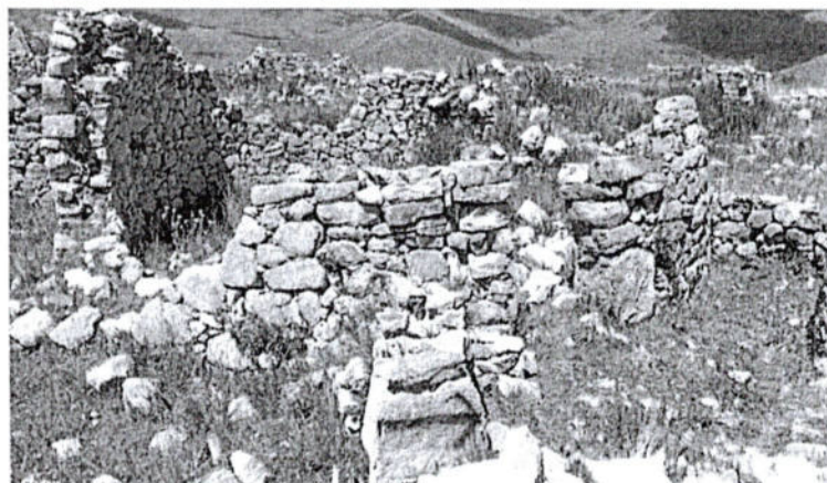
Foto.5: Vista de las estructuras arquitectónicas de planta circular de uso doméstico, la cual fue reconstruido el muro del vano del acceso. (inspección técnica 02/03/2026).
