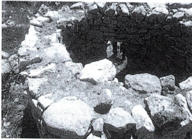
Foto.3: Vista de las estructuras arquitectónicas de planta circular donde se ha reconstruido la cabecera del muro. (inspección técnica 02/03/2026).
