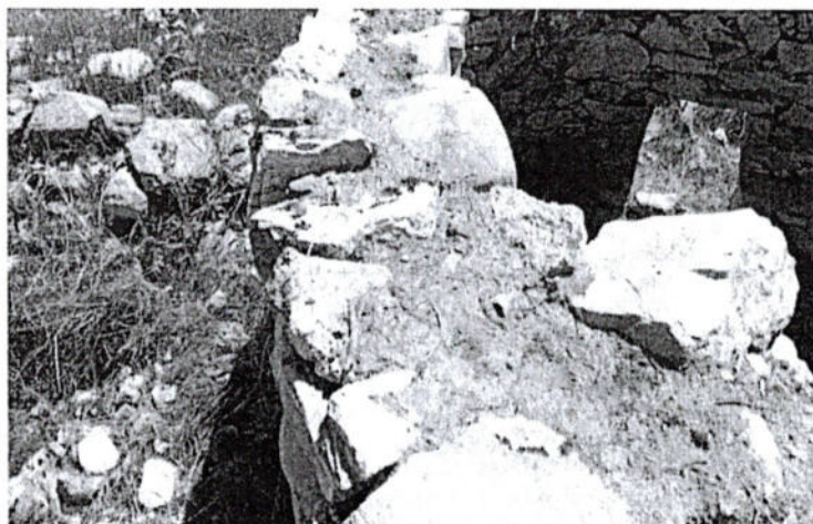
Foto.4: Vista de las estructuras arquitectónicas de planta circular donde se ha reconstruido la cabecera del muro. (inspección técnica 02/03/2026).
