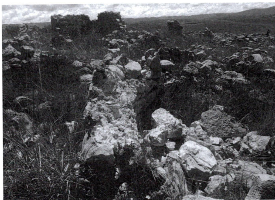
Imagen 13. Vista en detalle de muro colapsado por factores naturales (fuertes precipitaciones) (inspección 12/03/2026)
