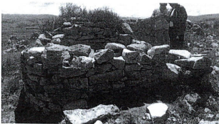
Foto.9: Vista de las estructuras arquitectónicas de planta circular de forma abovedado donde se realizó excavaciones y reconstrucción de muro. (inspección técnica 02/03/2026).
