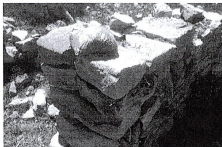
Foto.6: Vista de las estructuras arquitectónicas de planta circular de uso doméstico, la cual fue reconstruido el muro del vano del acceso. (inspección técnica 02/03/2026).
