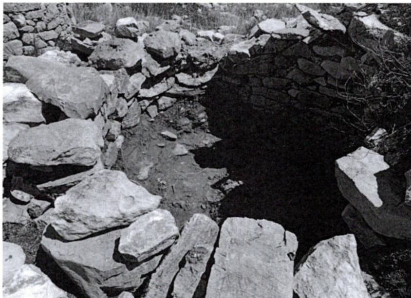
Imagen 03. Vista en detalle de la reconstrucción al muro prehispánico, donde se evidencia remoción de tierra al interior de una estructura circular en el sitio arqueológico de Chawin. (inspección 12/03/2026).
