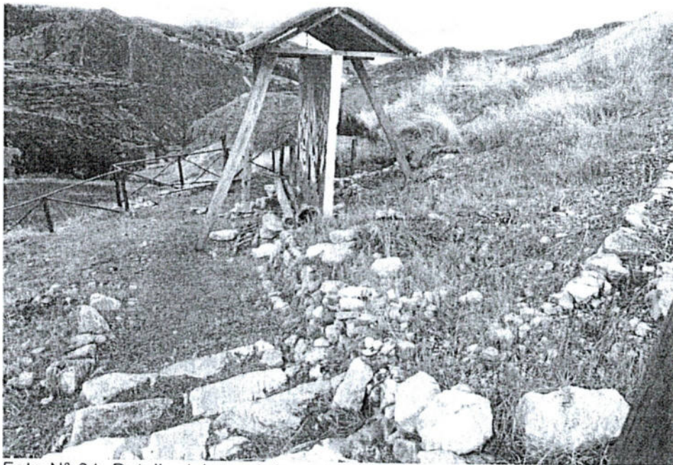
Foto N° 04: Detalle del panel de concreto armado con disposición de techo, presenta representación de temática cultural en el lateral del acceso habilitado de circuito turístico, sin el conocimiento ni la autorización expresa del Ministerio de Cultura.
