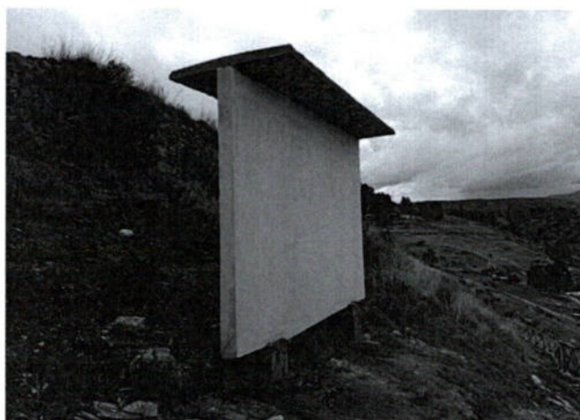
Imagen 10. Panel de concreto con dos soportes de concreto en proceso de elaboración. (inspección 27-02-2026)
