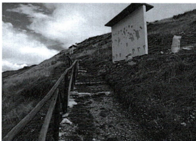
Imagen 9. Instalación de panel de concreto con techo de concreto de dos aguas, con inicio de una pintura mural. (inspección 27-02-2026)
