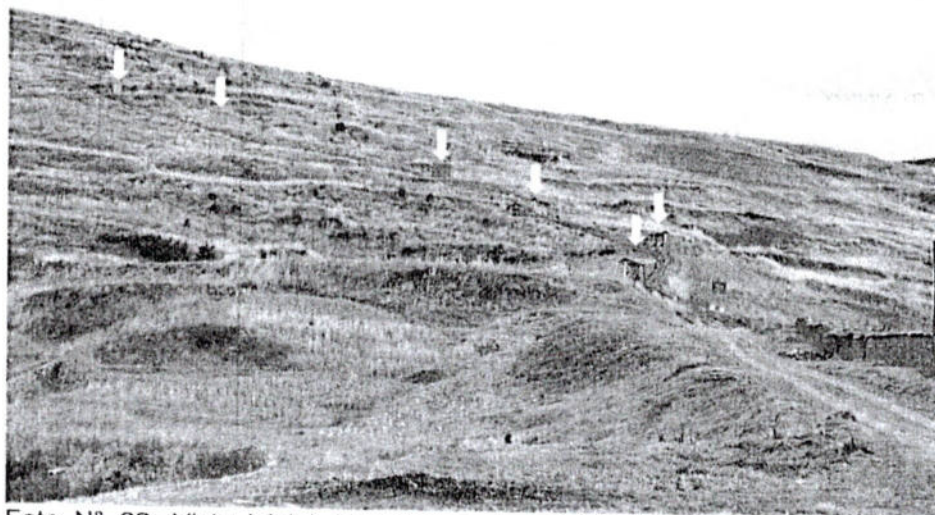
Foto N° 02: Vista inicial panorámico de habilitación de acceso de circuito al Sitio Arqueológico de Antahuacay, donde se observa construcción de paneles grandes de concreto armado.
