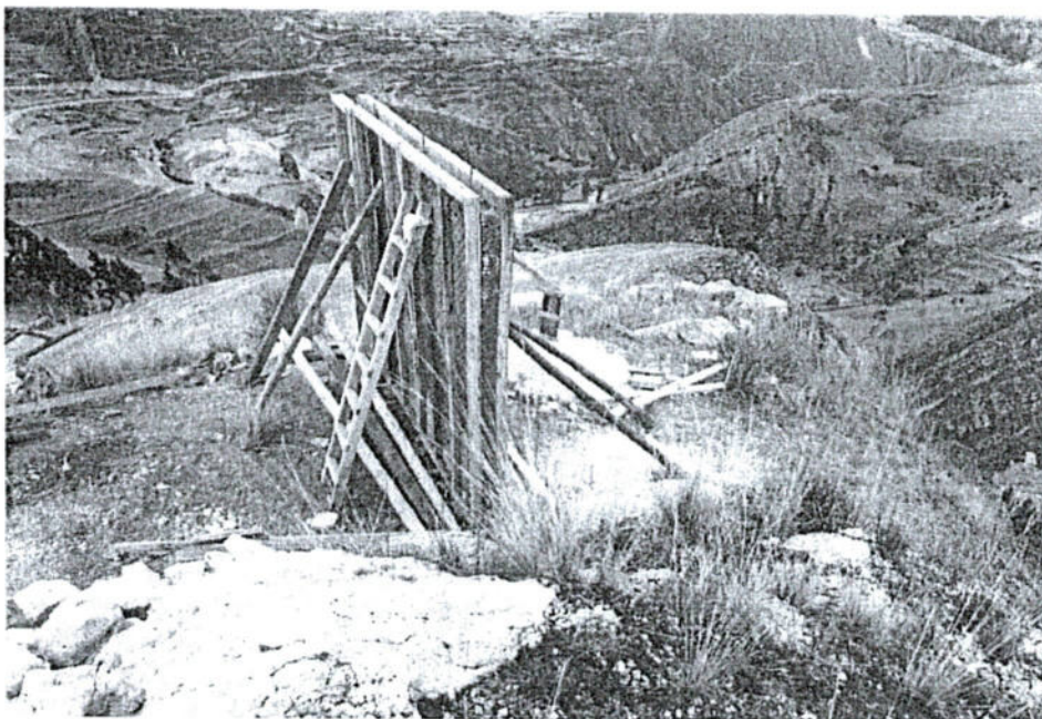
Foto N° 20: Vista de construcciones de paneles de concreto con encofrado proximo al acceso habilitado.
