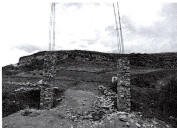
Imagen 2. Vista panorámica instalación de dos columnas de concreto adosados con piedras planas al lado oeste del sitio arqueológico de Antahuacay. (inspección 27-02-2026)
