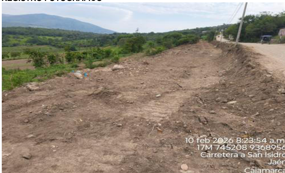
Foto N° 01.- Vista excavación con maquinaria pesada en la proximidad del vértice 2 del polígono del sitio arqueológico "San Isidro II". Arqueológico "San Isidro II".
