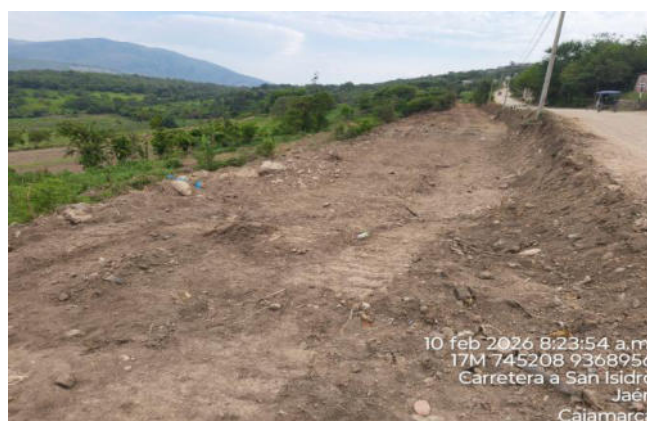
Foto 1.- Vista excavación con maquinaria pesada en la proximidad del vértice 2 del polígono del sitio arqueológico “San Isidro II”.
