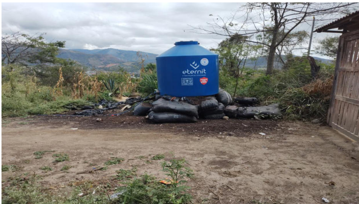
Foto 4.- Vista de tanque Rotoplas instalado en el área intangible del sitio arqueológico “San Isidro II”.
