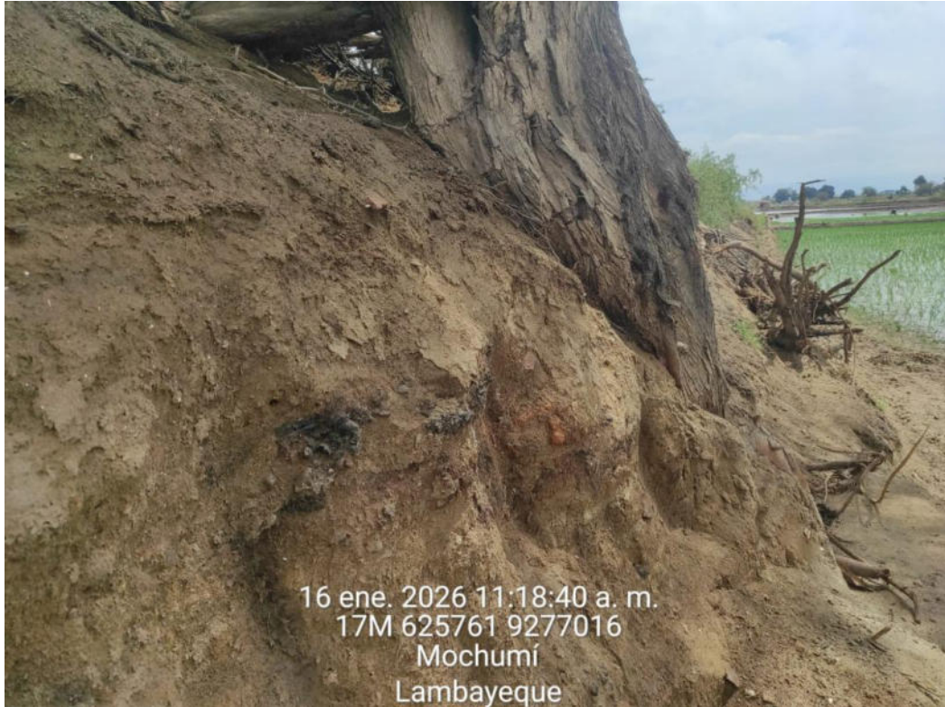
Foto 4: Vista a detalle de los pisos registrados en el perfil del corte realizado con maquinaria pesada, el presente perfil es del extremo norte del Sitio Arqueológico de Huaca Choloque.
