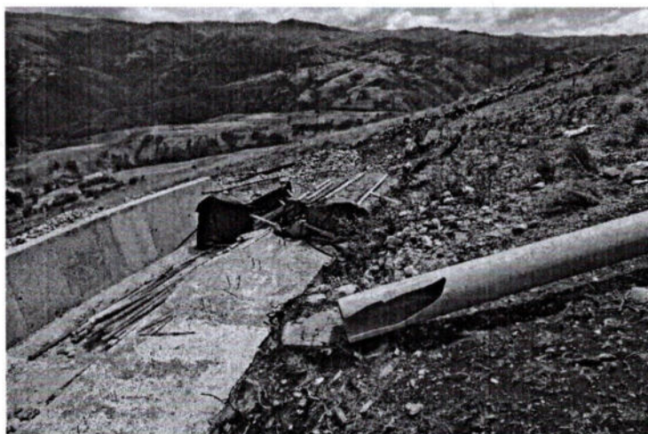
Imagen 6. Vista de la remoción de tierra con maquinaria pesada un área de 90m 2 ubicado fuera del polígono del sitio arqueológico. (inspección 13/02/2026).
