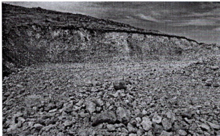
Imagen 5. Vista de la remoción de tierra con maquinaria pesada un área de 900m 2 ubicado fuera del polígono del sitio arqueológico. (inspección 07/01/2026).
