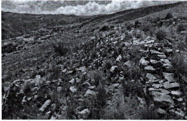
Imagen 2. muro de contención del sitio arqueológico de Pucará Sancristobalniyoq. (inspección 13/02/2026)
