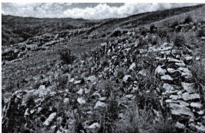
Foto 7. Vista de muro de contención del sitio arqueológico. (inspección 07/01/2026).
