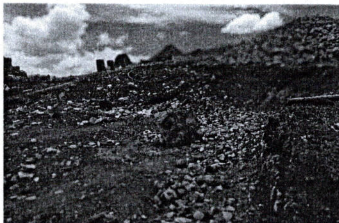
Foto 3. Vista de la remoción de tierra con maquinaria pesada un área de 40m 2 ubicado fuera del polígono del sitio arqueológico. (inspección 07/01/2026).
