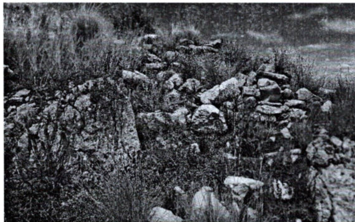
Imagen 03. Vista de muro de estructura arquitectónica en mal estado de conservación del sitio arqueológico de Pucará Sancristobalniyoq. (inspección 13/02/2026).
