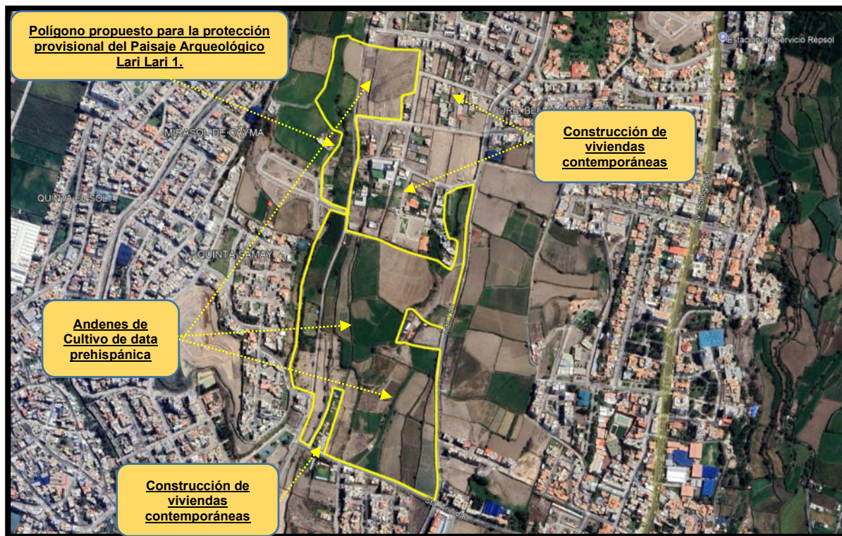
Imagen satelital N° 01, que muestra el polígono correspondiente a la propuesta de delimitación del Paisaje Arqueológico Larí Larí 1, para su protección provisional, verificando al interior del mismo, la evidencia cultural que viene siendo afectada por acciones antrópicas.
