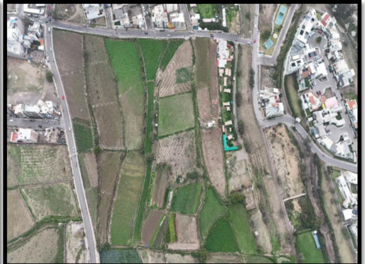
Foto N° 06, en el cual se puede visualizar espacios agrícolas que vienen cumpliendo la función para la cual fueron construidos.
