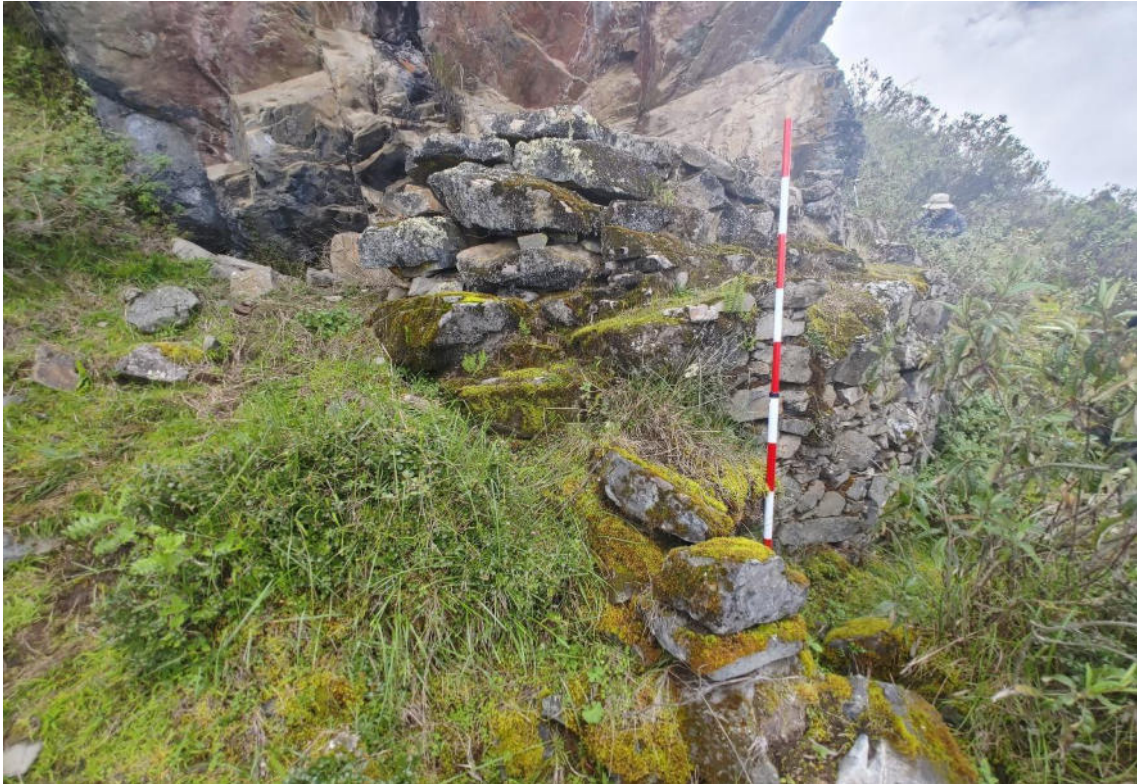
Imagen 05: Vista panorámica de muros de aterrazamientos.
