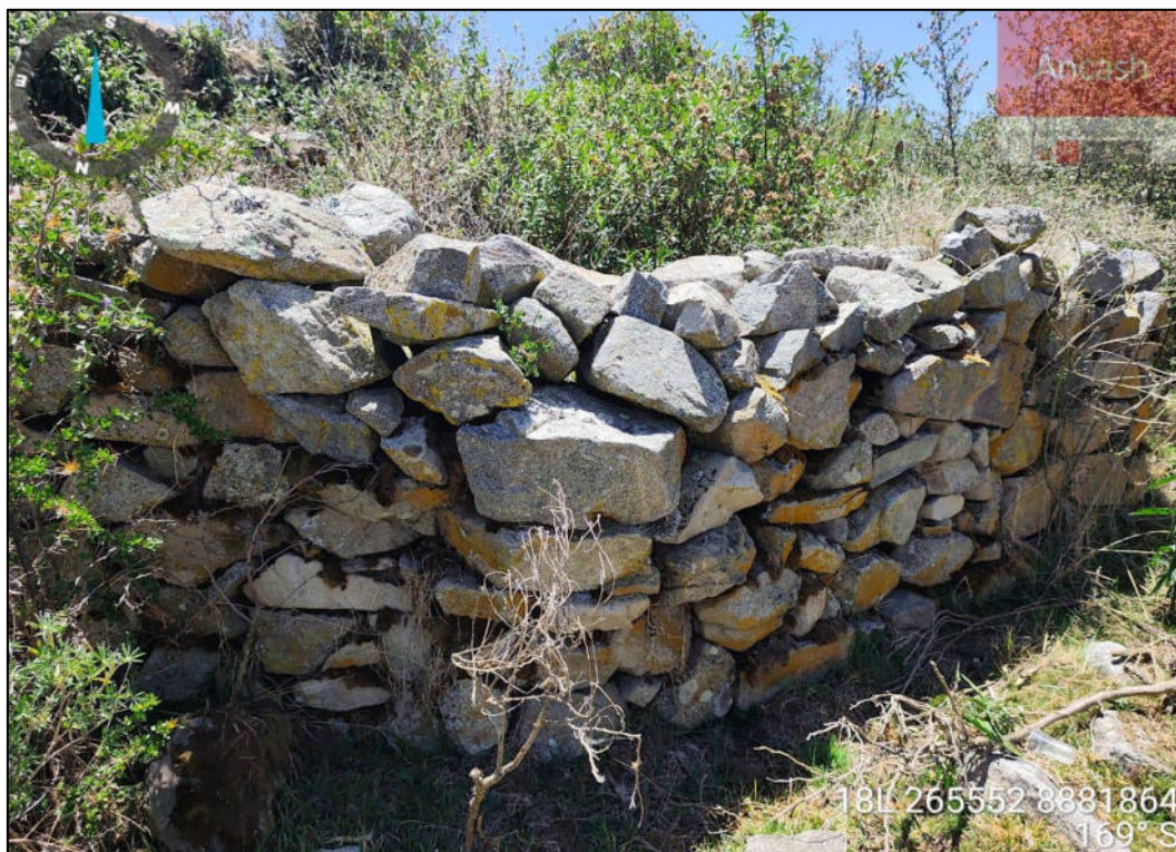
Imagen 06: vista panorámica de muros de recintos ubicados en el sector B.
