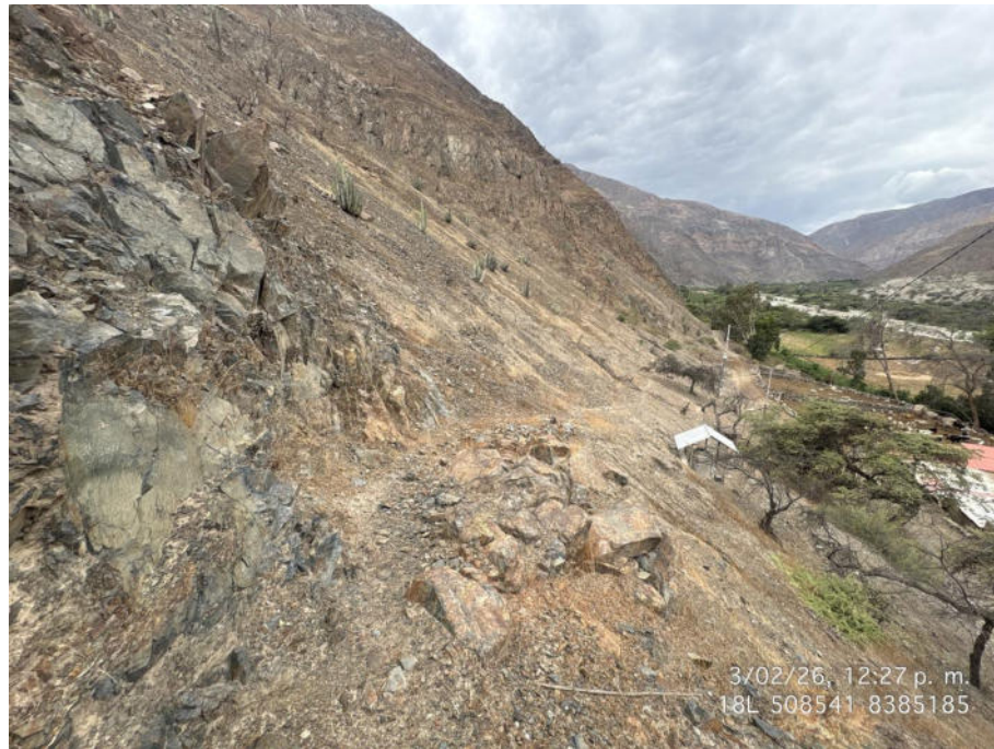
Fig. 05: Vista en detalle del camino con muro de sostenimiento.
