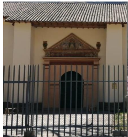
Portada lateral en el muro del Evangelio
