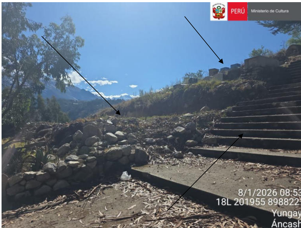
Imagen 02: vista panorámica del área de excavación, así como la construcción de la grada de cemento y en la cima se observa nichos de cementerio contemporáneo.
