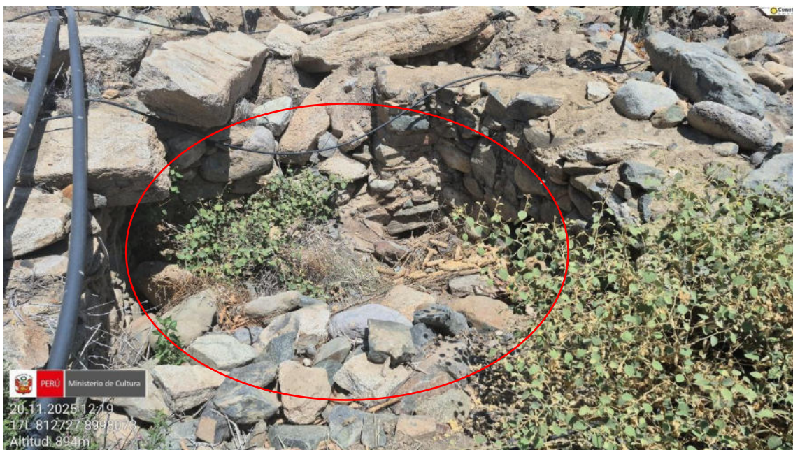
Imagen 02: recinto cuadrangular los cuales expuesto al tendido de manguera de agua.
