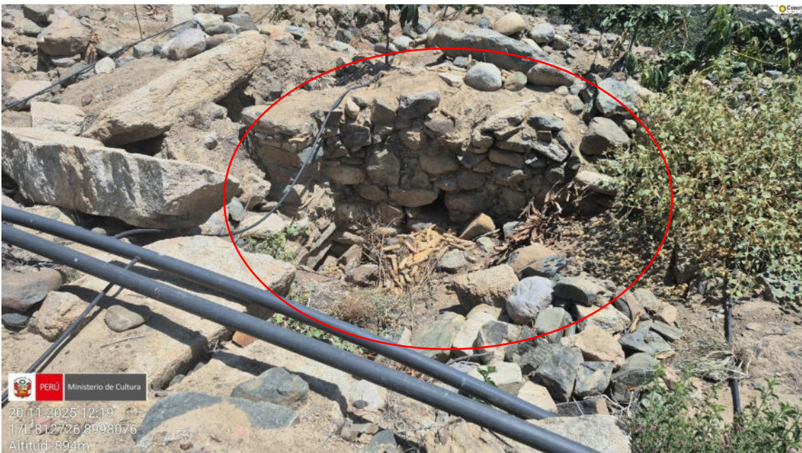
Imagen 04: recintos arquitectónicos en medio de plantaciones y el tendido de manguera.
