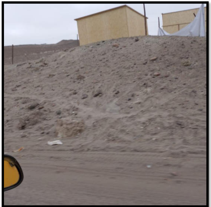
Foto N° 02: imagen fotográfica en el que se puede apreciar las construcciones contemporáneas de un solo nivel elaborados con materiales diversos (ref. vistas fotográficas de Whatsapp).
