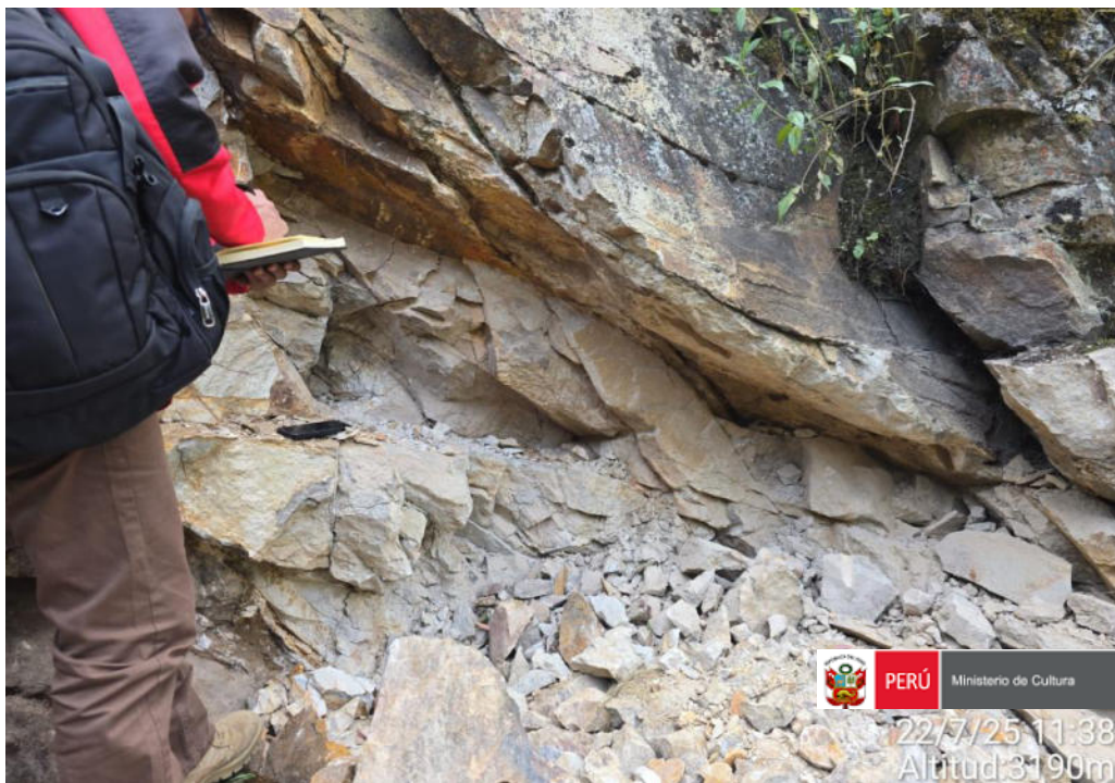
Imagen 04: vista a detalle de trabajos realizados con fines de extracción mineral.
