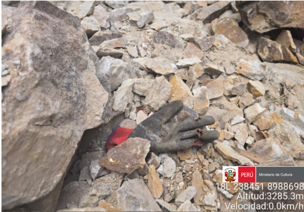
Imagen 03: vista a detalle de la extracción de rocas producto de voladuras con material explosivo.
