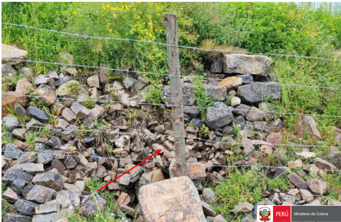
Imagen 04: vista a detalle de muros arquitectónicos y junto a ello se instalaron cercos de palos con alambres de púa.
