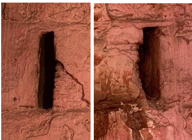
Vistas de vanos de ventilación ("respiraderos") desde el interior
