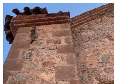
Detalle del remate de muros de piedra
