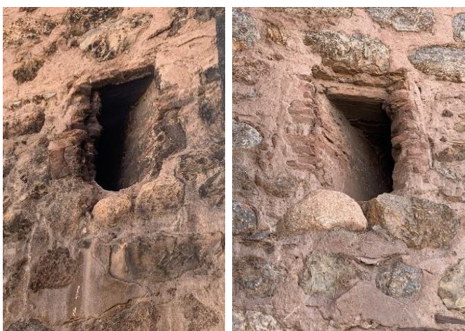
Vistas de vanos de ventilación (respiraderos) desde el exterior
