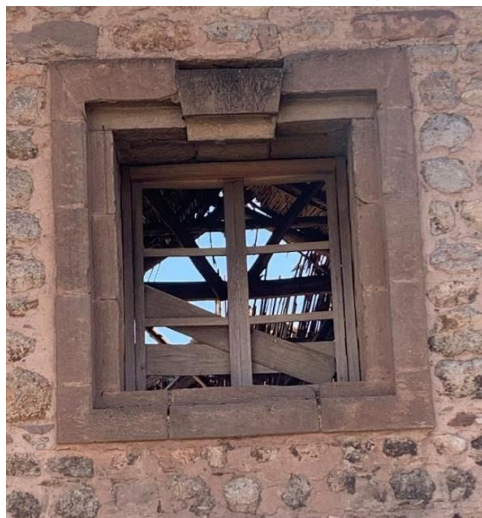
Detalle de vano enmarcado por doble jamba de piedra en fachada posterior
