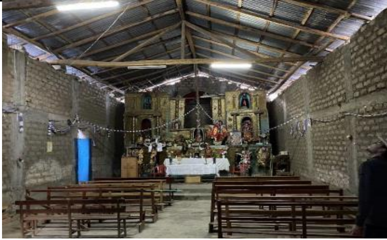
Vista de la nave el cual presenta una cobertura de diseño estructural con celosía con calamina
