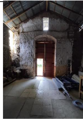
Vista de la nave el cual presenta una cobertura de diseño estructural con celosía con calamina
