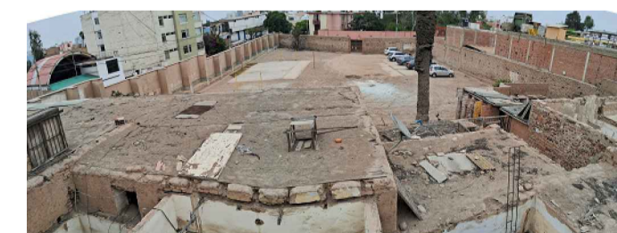
Techos de ambientes del A-105 al A-114
