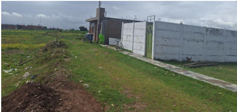
Foto 4. Vista de la construcción de viviendas y estructuras en concreto armado al interior del polígono de delimitación de Patan coto sector 1.
