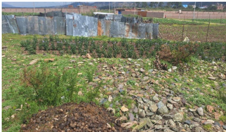
Foto 6. Vista de la construcción de cerco perimétrico con palos de madera y calamina al interior del polígono de delimitación de Patan coto sector 1.
