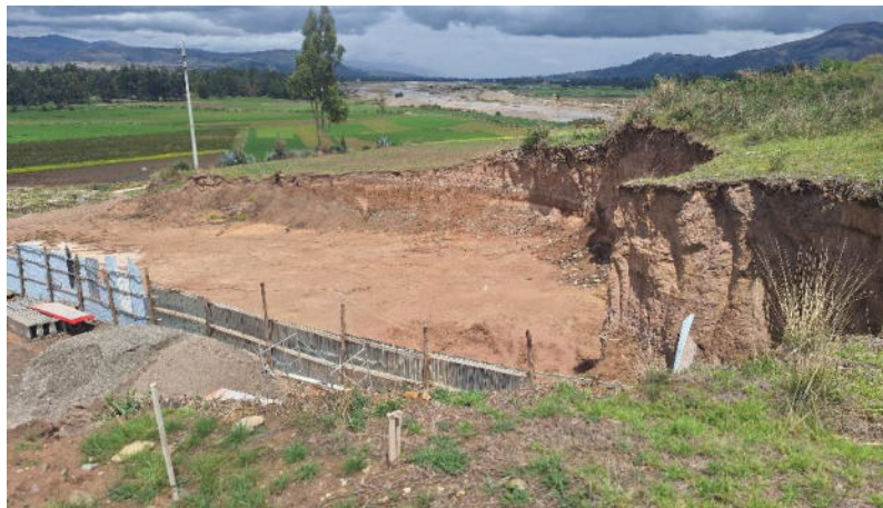
Foto 13. Vista de la excavación con maquinaria pesada al interior del polígono de delimitación de Patan coto sector 2.
