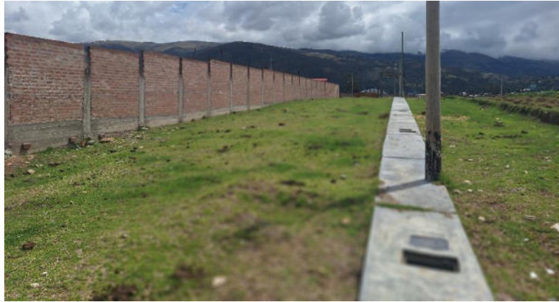
Foto 7. Vista de la construcción de cerco perimétrico y construcción de veredas y postes al interior del polígono de delimitación de Patan coto sector 1.
