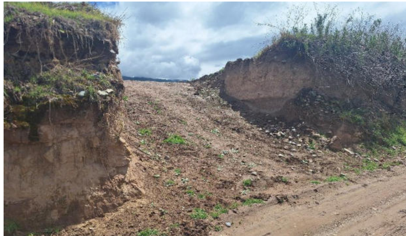
Foto 12. Vista de la excavación de acceso para ingreso de maquinaria agrícola al interior del polígono de delimitación de Patan coto sector 2.
