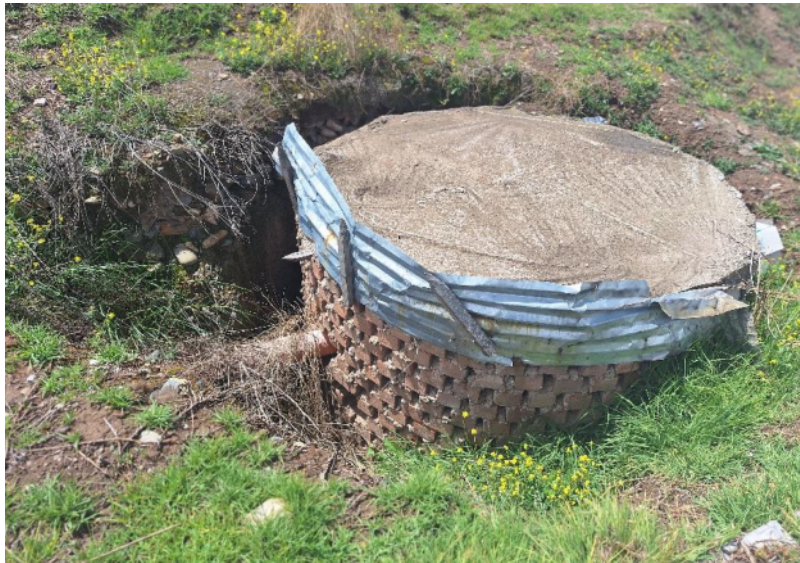
Foto 8. Vista de la construcción de un buzón con ladrillos y cemento al interior del polígono de delimitación de Patan coto sector 1.
