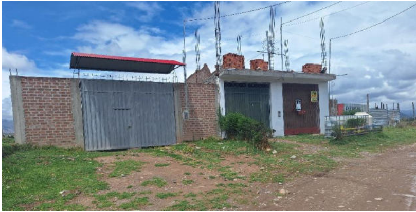
Foto 11. Vista de la construcción de viviendas con material noble al interior del polígono de delimitación de Patan coto sector 1.
