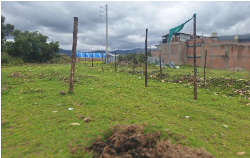
Foto 15. Vista de la instalación de cerco perimétrico con palos de madera y en algunos puntos alambre con puas al interior del polígono de delimitación de Patan coto sector 2.
