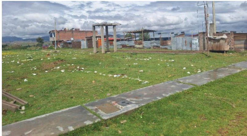
Foto 3 Vista de la construcción de viviendas y estructuras en concreto armado al interior del polígono de delimitación de Patan coto sector 1.
