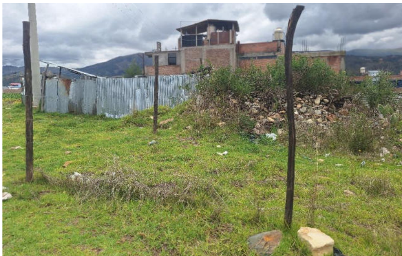
Foto 16. Vista de la instalación de cerco perimétrico con palos de madera y calamina al interior del polígono de delimitación de Patan coto sector 2.
