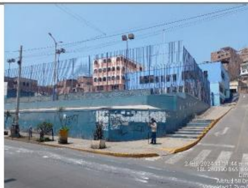
Cruce de la calle C y Av. Vía Central
