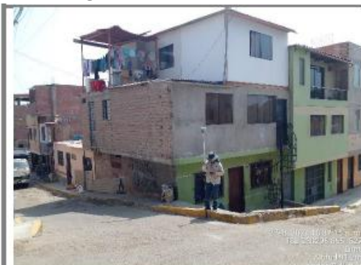
Cruce de la calle Uno con calle S/N
