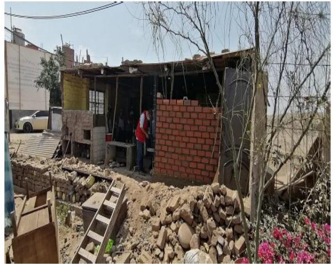
Foto 3. Zona Arqueológica Garagay. Vista tomada durante la inspección de campo de fecha 20 de enero del 2022, donde se observa que el muro de adobe ya fue derribado y en su lugar se está construyendo un muro de material noble.
