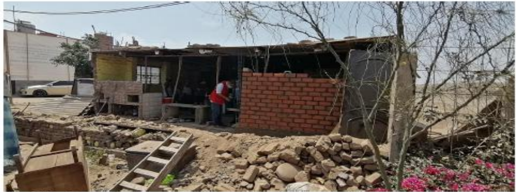
Foto 3. Zona Arqueológica Garagay. Vista tomada durante la inspección de campo de fecha 20 de enero del 2022, donde se observa que el muro de adobe ya fue derribado y en su lugar se está construyendo un muro de material noble.
