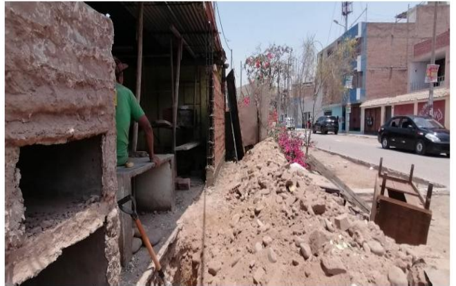
Foto 5. Zona Arqueológica Garagay. Vista tomada durante la inspección de campo de fecha 20 de enero del 2022, donde se observa el muro de ladrillos que va siendo levantado en el lugar y la estructura de hierro para las columnas que darán soporte a la construcción.
