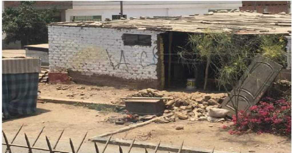
Foto 2. Zona Arqueológica Garagay. Imagen proporcionada mediante la denuncia de fecha 19 de enero del 2022 (D0056-22), donde se observa que el muro de adobe del lado sur del comedor popular 12 de agosto ya se encuentra en proceso de desmontaje.
