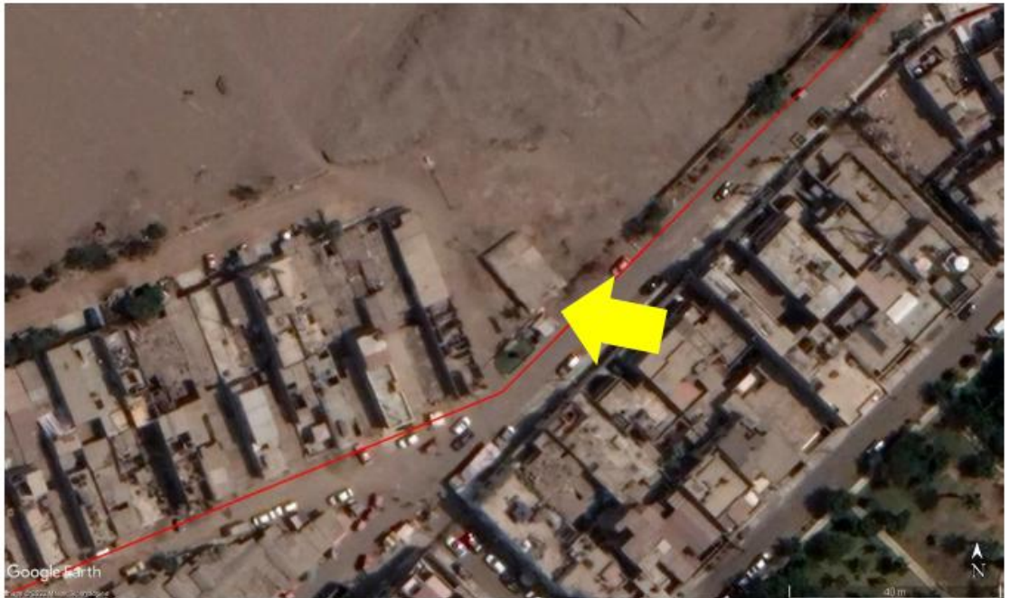
Imagen 2: Vista Satelital de Google Earth, donde se observa en detalle el área donde se ubica el comedor popular 12 de agosto y el lado donde se han desarrollado las obras de construcción de un muro de material noble en reemplazo de un muro de adobe.
