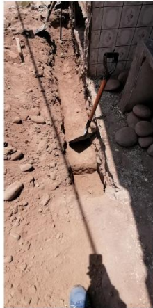
Foto 4. Zona Arqueológica Garagay. Vista tomada durante la inspección de campo de fecha 20 de enero del 2022, donde se observa la zanja elaborada en el terreno para la construcción de las bases de concreto que darán soporte al muro de ladrillos en proceso de construcción al interior del área intangible.
