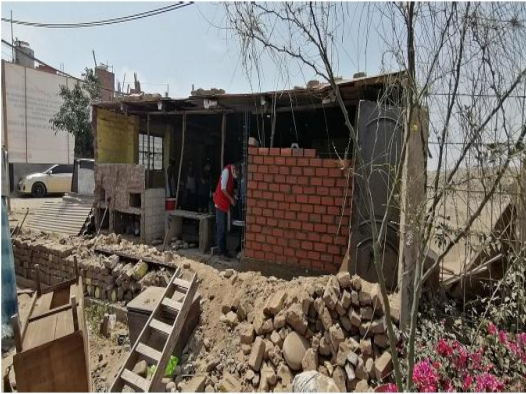
Foto 3. Zona Arqueológica Garagay. Vista tomada durante la inspección de campo de fecha 20 de enero del 2022, donde se observa que el muro de adobe ya fue derribado y en su lugar se está construyendo un muro de material noble.
