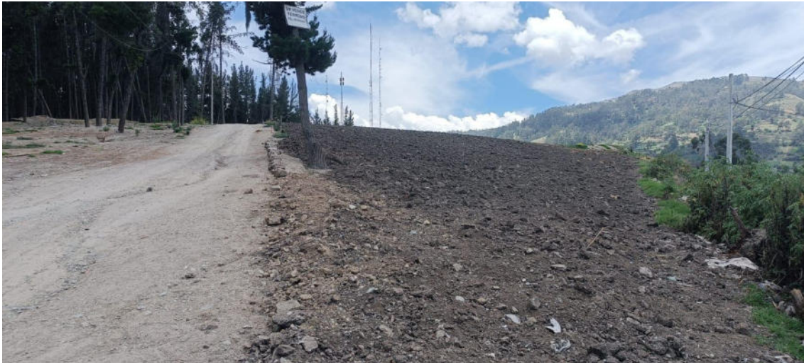
Foto N°007. Vista en detalle de la apertura de la trocha carrozable y colocación de antena de TV en el sitio arqueológico Apu Huayhuaca (Waywaka).
