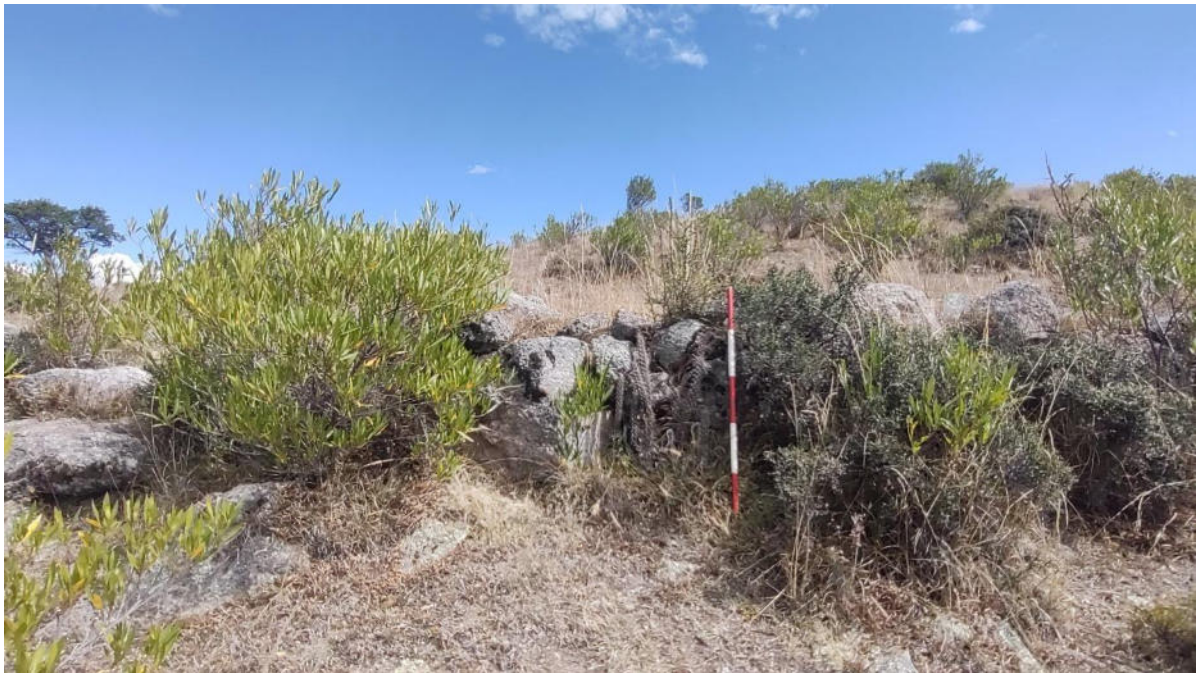
Imagen 04. Muro perimétrico que circunscribe la parte media de la ladera que contiene las evidencias arqueológicas. Nótese su altura y estado de conservación.
