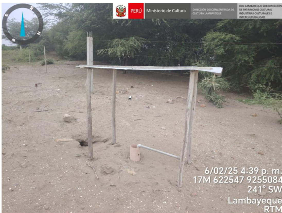
Foto 4: Vista a detalle de otra afectación por instalación de tubería dentro del área del Sitio Arqueológico Huaca Santo Tomas.
