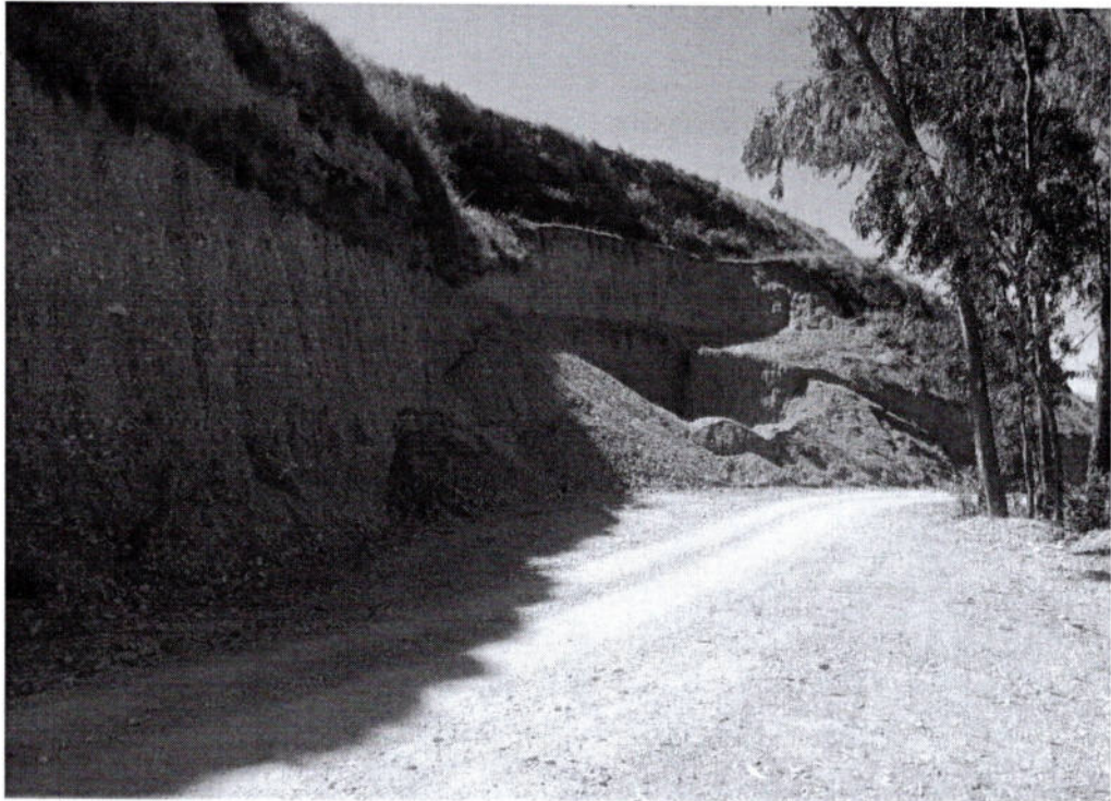
Imagen 12, evidencia de extracción de material no metálico, que está debilitando el talud donde se ubican las estructuras de las colcas (almacenes) en el sitio arqueológico de Llullupata (inspección 13-11-2025).
