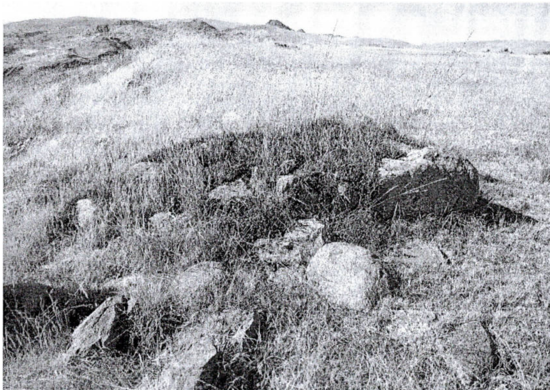
Foto. 2: vista de estructuras arquitectónicas colapsados y en mal estado de conservación del
