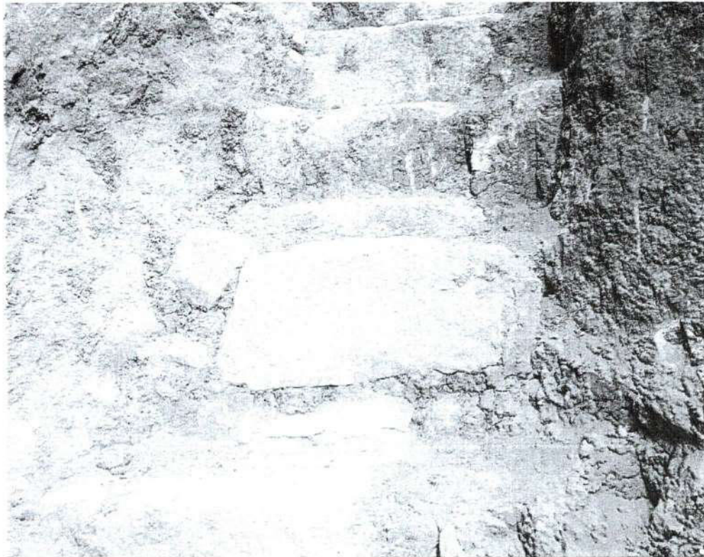
Foto.6: Vista de la escalinata donde las piedras sufrieron golpes, fracturas y raspaduras con
