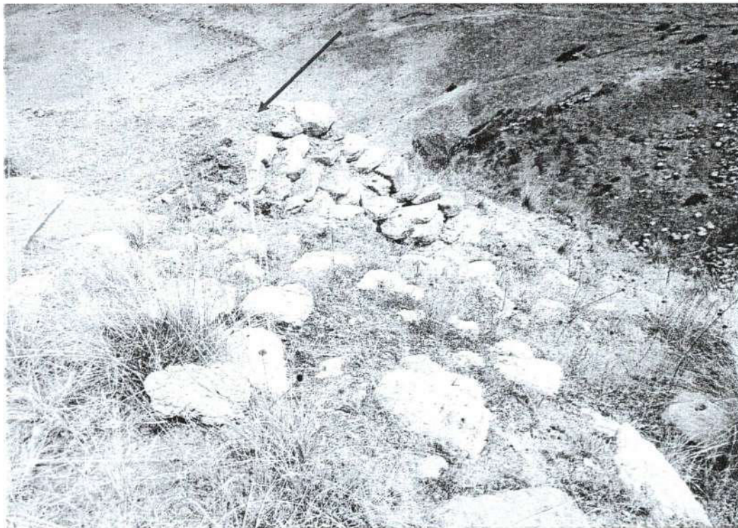
Foto.14: Vista de la estructura forma semicircular donde se ha cubierto la cabecera de muro con tierra. (inspección técnica 20/08/2024).
