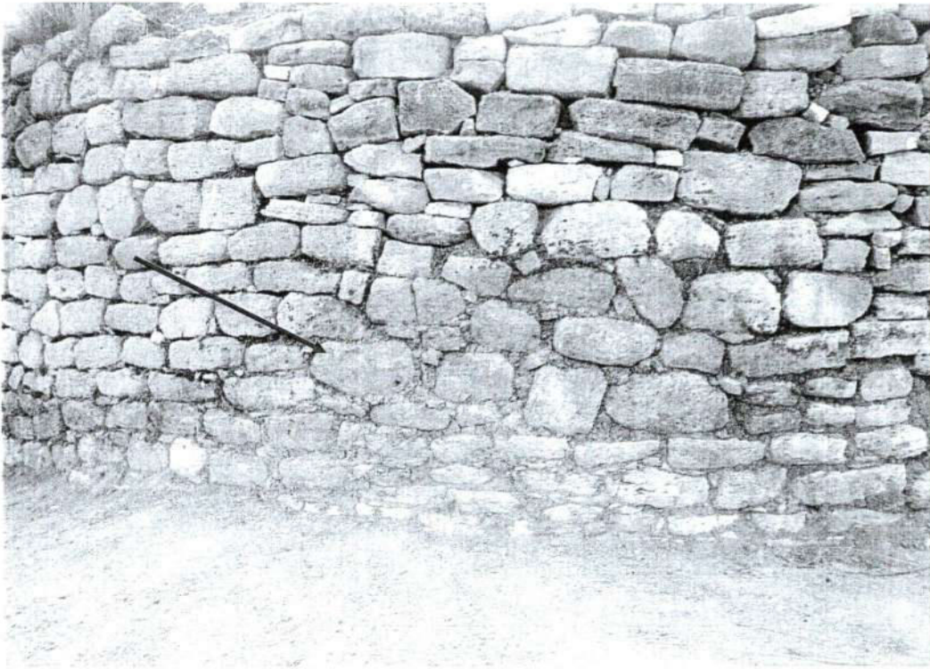
Foto.9: Vista de la estructura o plataforma superior en forma semicircular donde se ha excavado algunos rellenos que cubrían el muro. (inspección técnica 20/08/2024).
