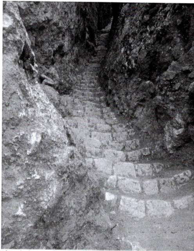
Foto 5. Vista panorámica de la escalinata del sitio arqueológico de Waly, la cual fue afectado por utilizar pico y barreta para remover la tierra superficial que cubría la escalera, causando incisiones y fracturas en las piedras de la escalinata (inspección: 13/11/2025).
