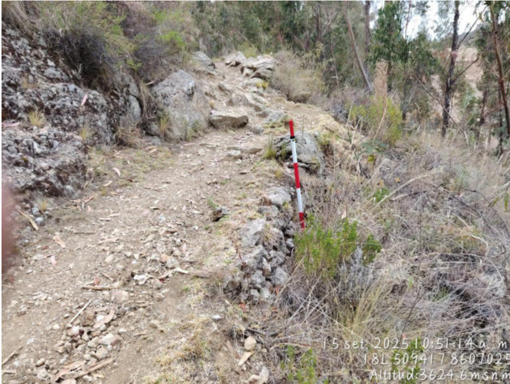
fotografía 12 vista panorámica del Camino Prehispánico, presenta muro de contención que esta hecha a base de piedras secas y argamasa, este presenta una altura de 0.80 cm, en algunos tramos se puede observar este tipo de muros como contención.
