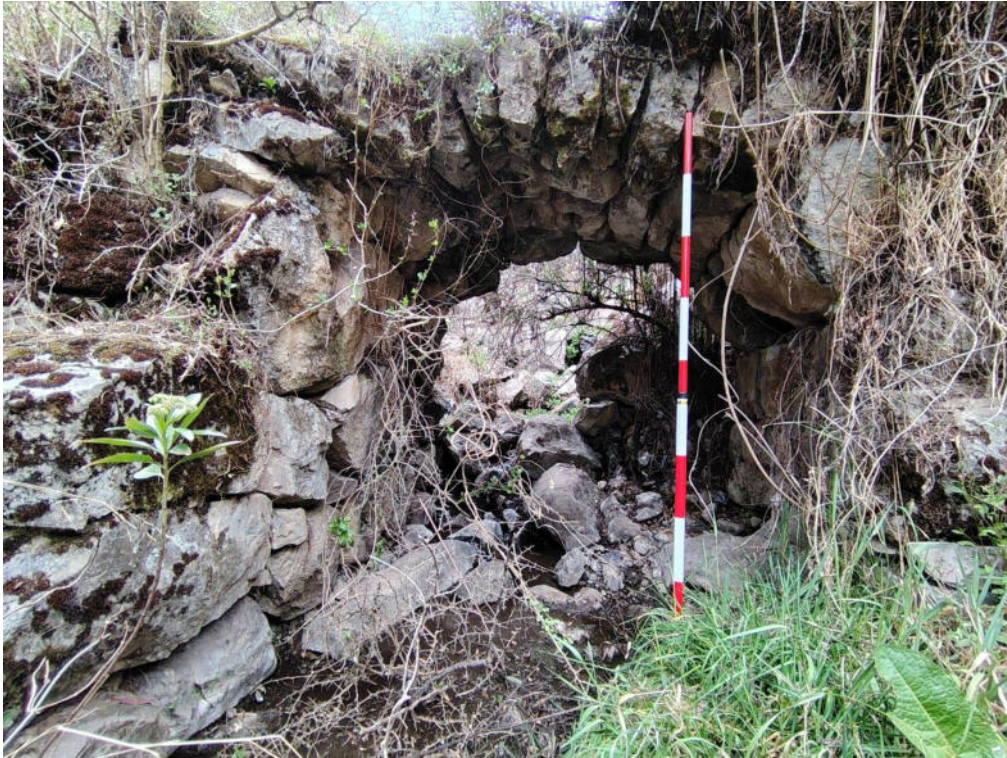
fotografía 6 vista en detalle del puente que se encuentra en un uno de los puntos del Camino Prehispánico, los puentes en la época prehispánico eran muy importantes. Por qué facilitó el intercambio comercial y otro Utilizados para cruzar ríos o quebradas más cortas. Los de piedra eran a menudo losas de roca apoyadas sobre estribos (bases) de piedra.
