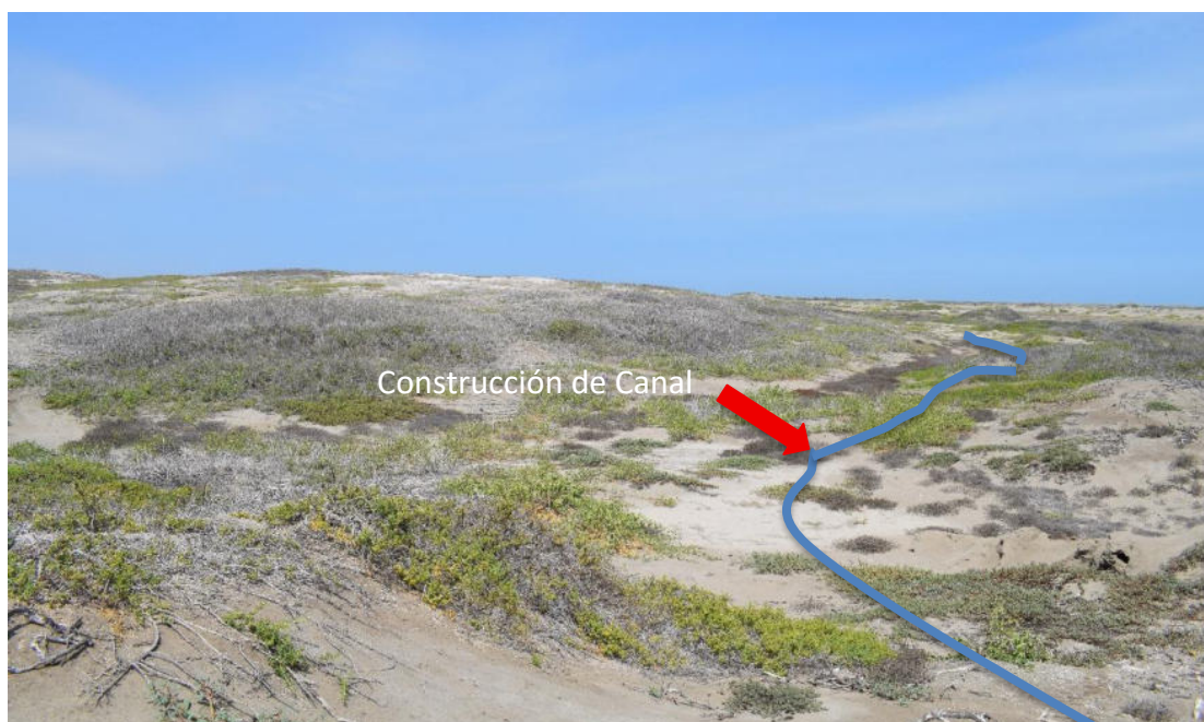
Foto 2: Vista panorámica de la construcción de canal con maquinaria pesada, causando impacto el lado noroeste del área nuclear del sitio arqueológico Huaca Blanca Norte. 12-10-2025.
