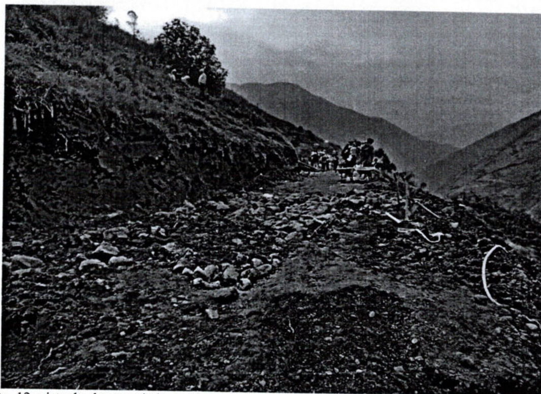
Foto. 12: vista de algunas piedras pertenecientes a muros de contención de las andenerías, las cuales se encuentran tendidas sobre la trocha carrozable (inspección 09/10/2024).
