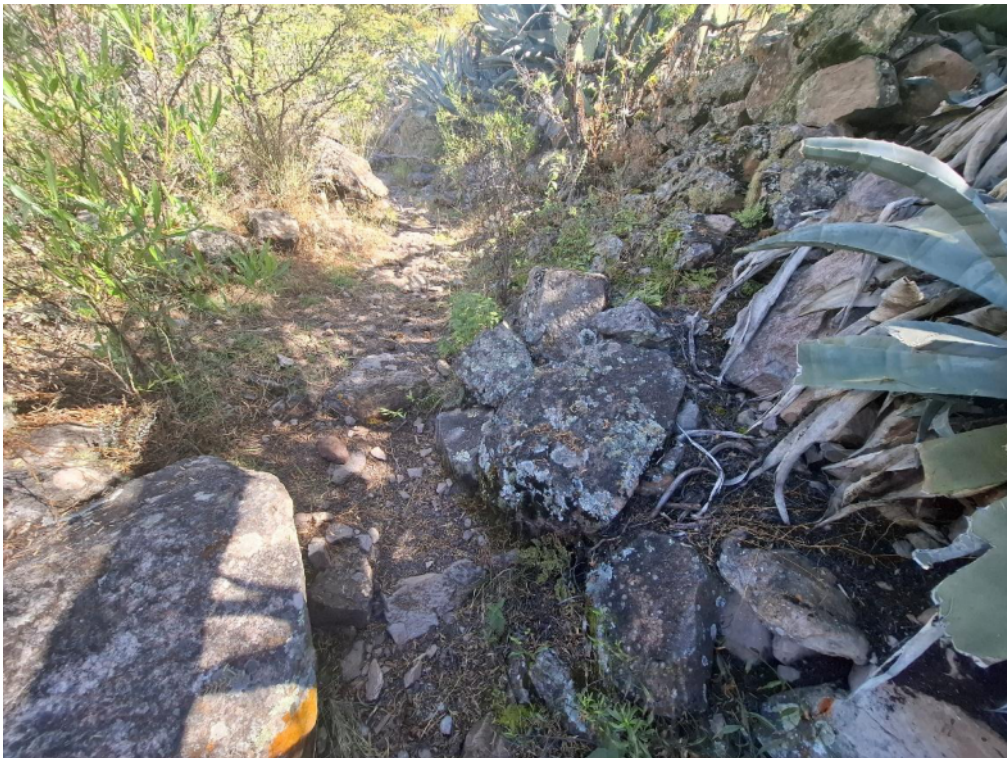
Fotografía 3 Vista en detalle de un segmento del camino prehispánico, el cual evidencia una sólida construcción vial. Claramente, se observa que en ambos lados del sendero se han levantado muros de contención de aproximadamente 1.10 m de altura, contruidos íntegramente a base de piedras locales
