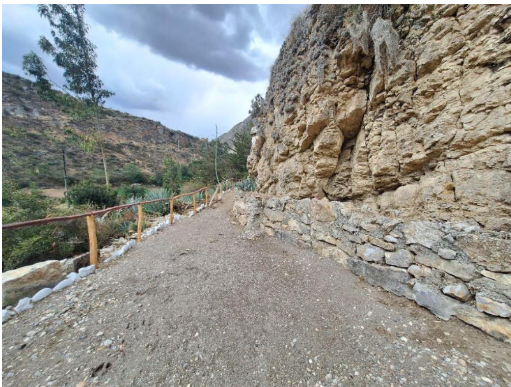
Fotografía 5. Detalle del camino prehispánico, cuyo muro lateral ha sido modificado o reconstruido con materiales de la zona (segunda inspección).
