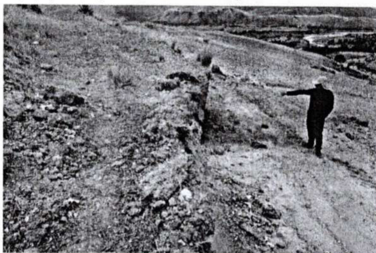
Foto.5: Vista del Qhapaq ñan, donde se evidencia el corte de la calzada y plataforma realizado con maquinaria pesada. (inspección técnica 13/10/2025).
