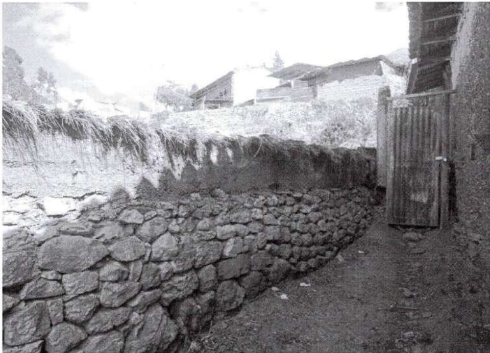
Foto 7. Vista panorámica de afectación por construcción de tapial sobre una terraza prehispánica en el complejo arqueológico monumental de Tarmatambo (Inspección 16/10/2025).
