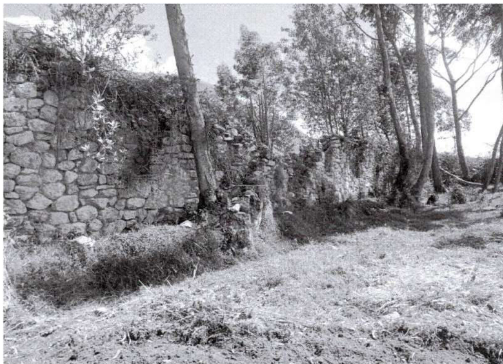
Foto 3. Vista panorámica del muro lateral de la kallanka donde se evidencia el colapso del muro del complejo arqueológico monumental de Tarmatambo debido a la raíz de eucalipto. (Inspección 16-10-2025).
