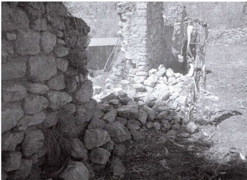
Foto 2. Vista en detalle del colapso de muro de la kallanka del sitio complejo arqueológico monumental de Tarmatambo (Inspección 16-10-2025).
