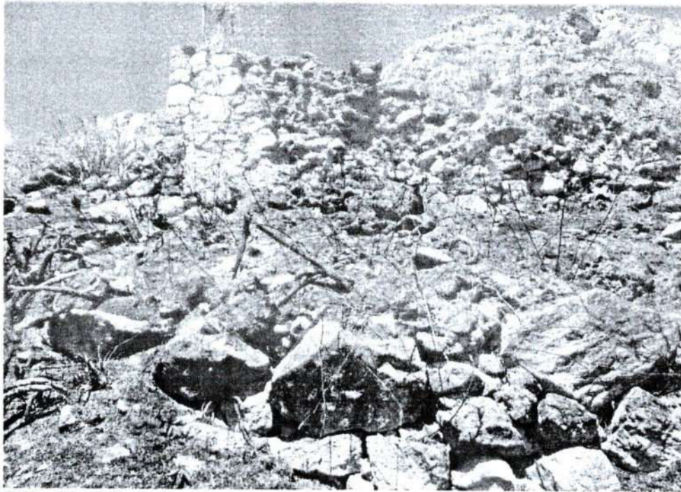
Foto. 13: vista de la estructura de forma cuadrangular donde se evidencia la afectación a la estructura física del paramento del muro externo, así mismo se evidencia colapso de muro (imagen de inspección de fecha 06/08/2025).
