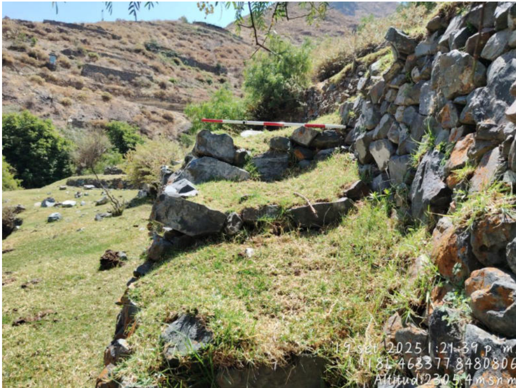
Fotografía 10 vista en detalle de los accesos a las terrazas, estos accesos están construidos con piedras de la zona y de diferentes formas y tamaños.
