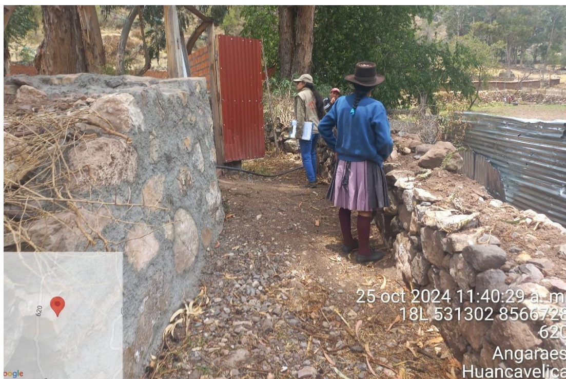
Imagen 4. Vista fotográfica general del camino prehispánico alterado por un muro perimétrico de concreto y material noble, además se aprecia el uso de cemento para unir las piedras del muro prehispánico.
