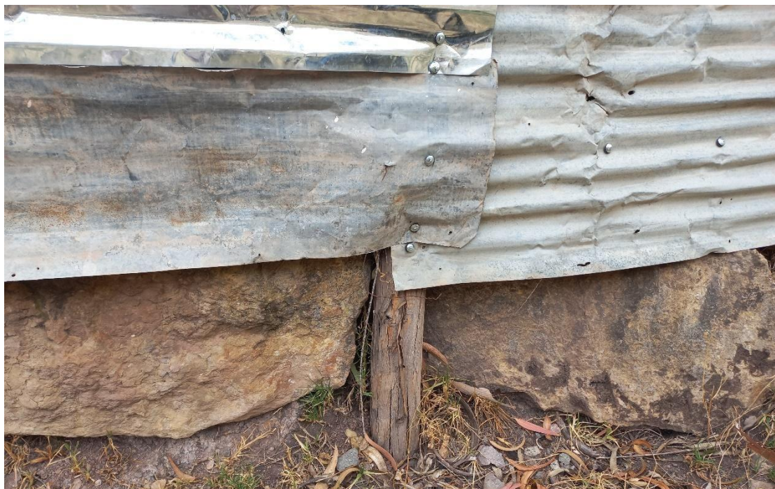
Imagen 7. Vista fotográfica en detalle del muro perimétrico metálico hecho por calaminas y troncos que altera y cubre el muro lateral del camino prehispánico
