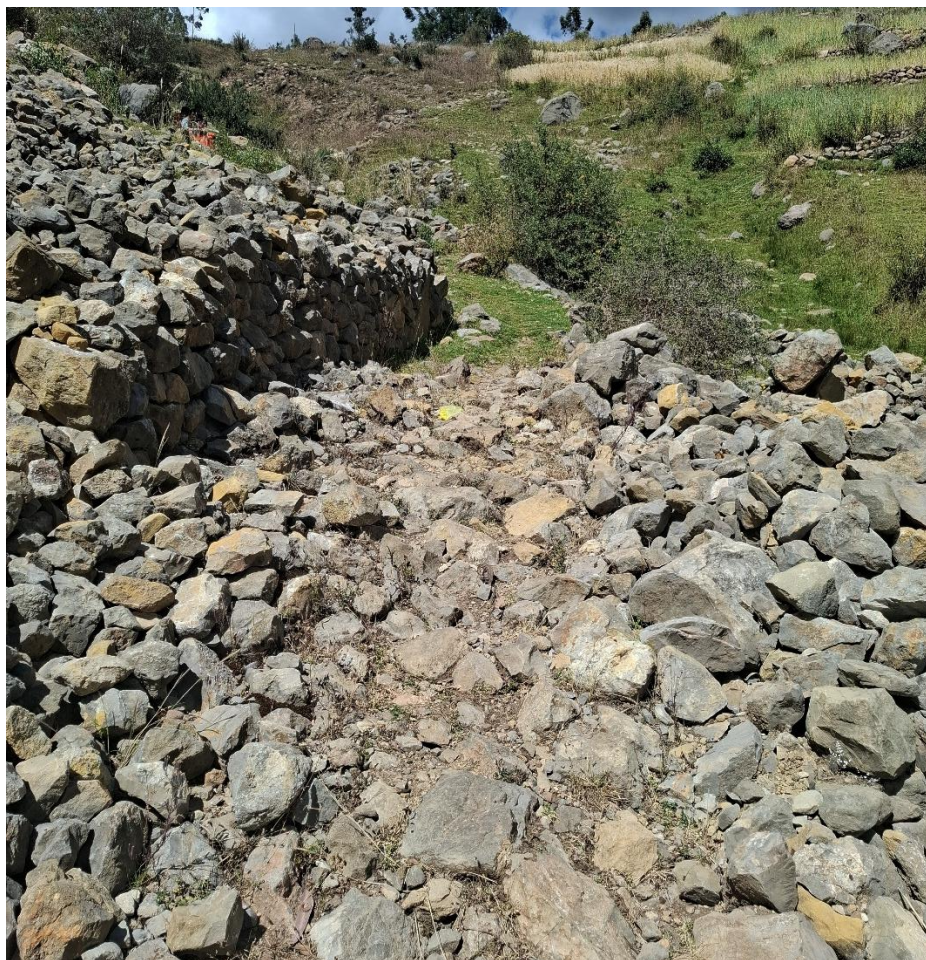
Fotografía 2. Desprendimientos de roca generados por la ejecución de una obra, que han caído sobre la calzada del camino prehispánico..
