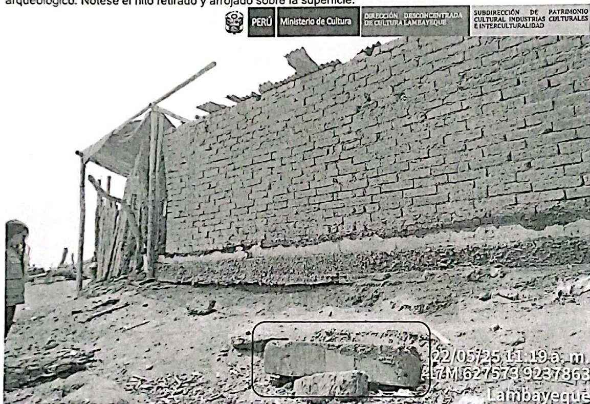
IMAGEN N°05: vista posterior de la afectación por asentamiento de estructura en el lado este del sitio arqueológico. Nótese el hito retirado y arrojado sobre la superficie.
