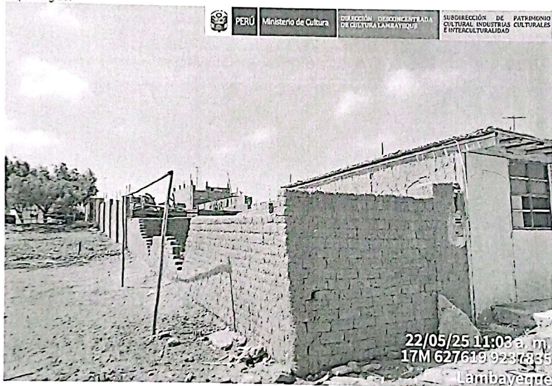
IMAGEN N°03: vista de la afectación por asentamiento de estructura de adobe en el lado sureste del sitio arqueológico.
