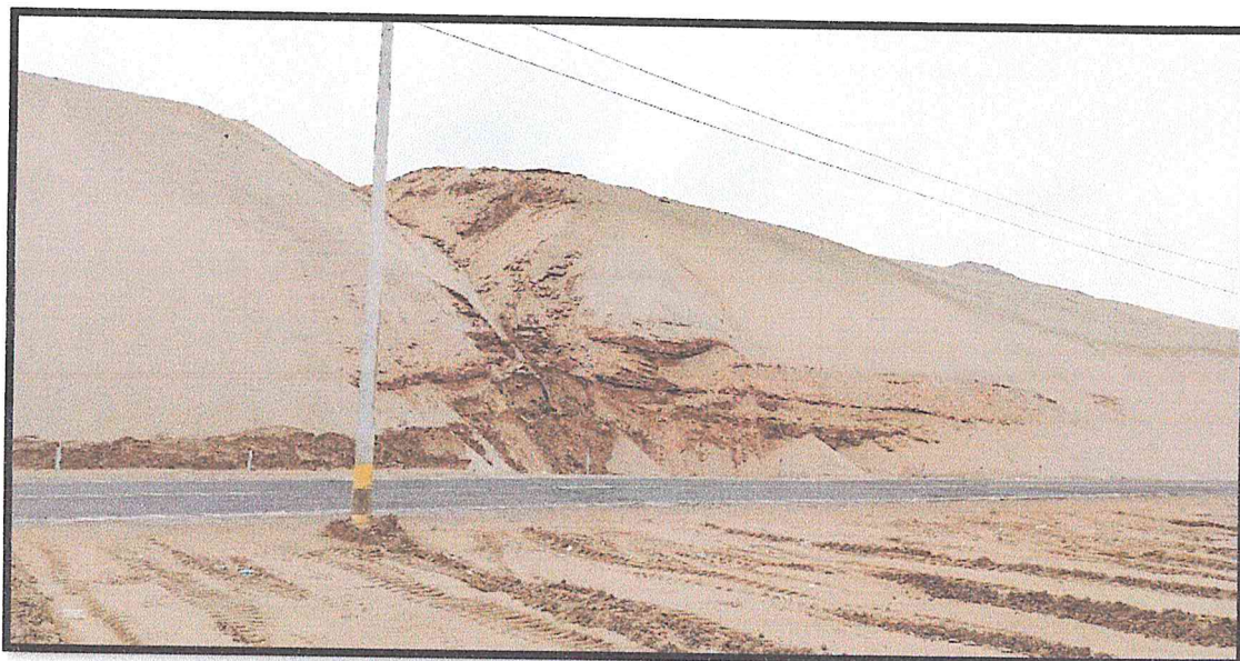
Foto N° 5: Deslizamiento de tierra, a causa de las lluvias.
