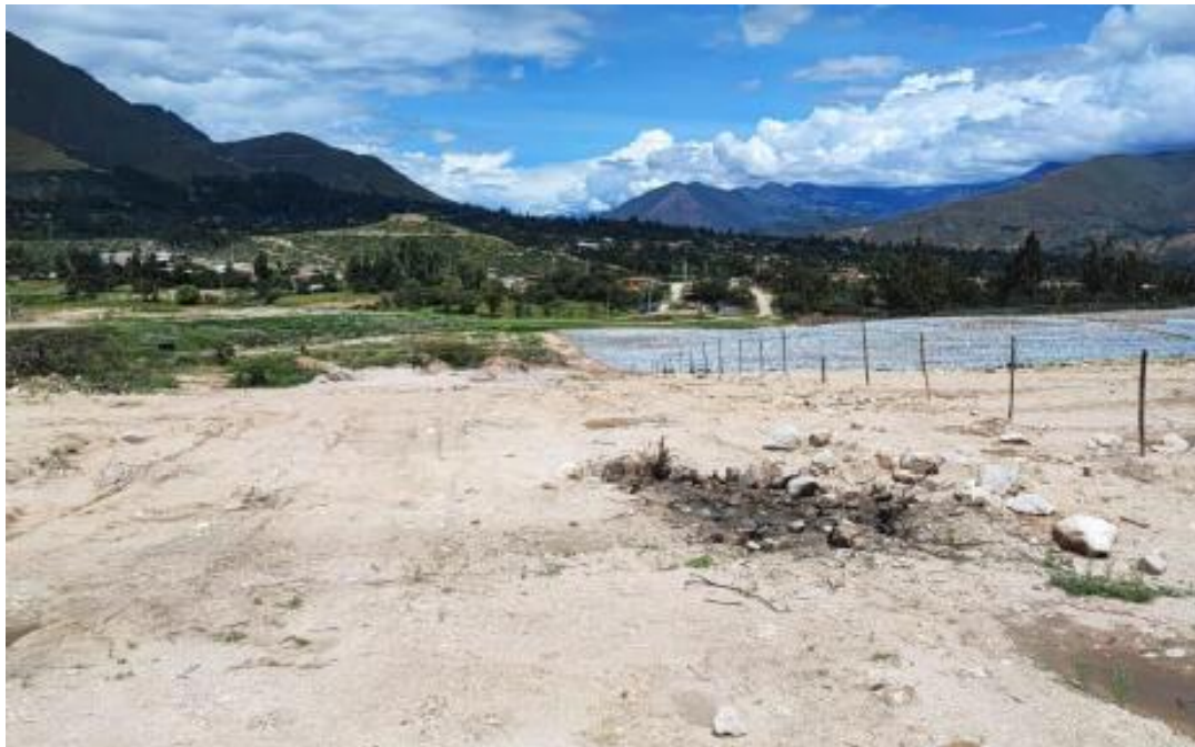
Foto 2: Sitio Arqueológico Pampa Irka. Durante la inspección desarrollada con fecha 23 de junio de 2025, se aprecia dentro de la poligonal arqueológica, sector nor-oeste, la apertura de una trocha carrozable e instalación de cerco perimétrico compuesto por postes de madera y alambre de púas.
