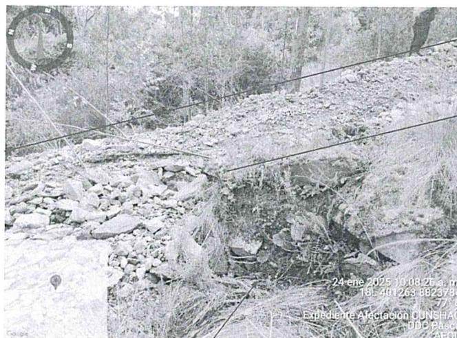
Imagen N°07 "Vista del Muro 2 que fue afectado casi en su totalidad por el deslizamiento"
