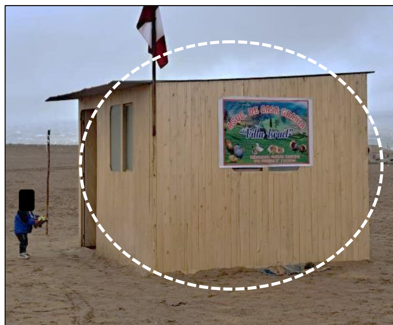
Imagen N°2: Inspección del 16 de agosto de 2024
