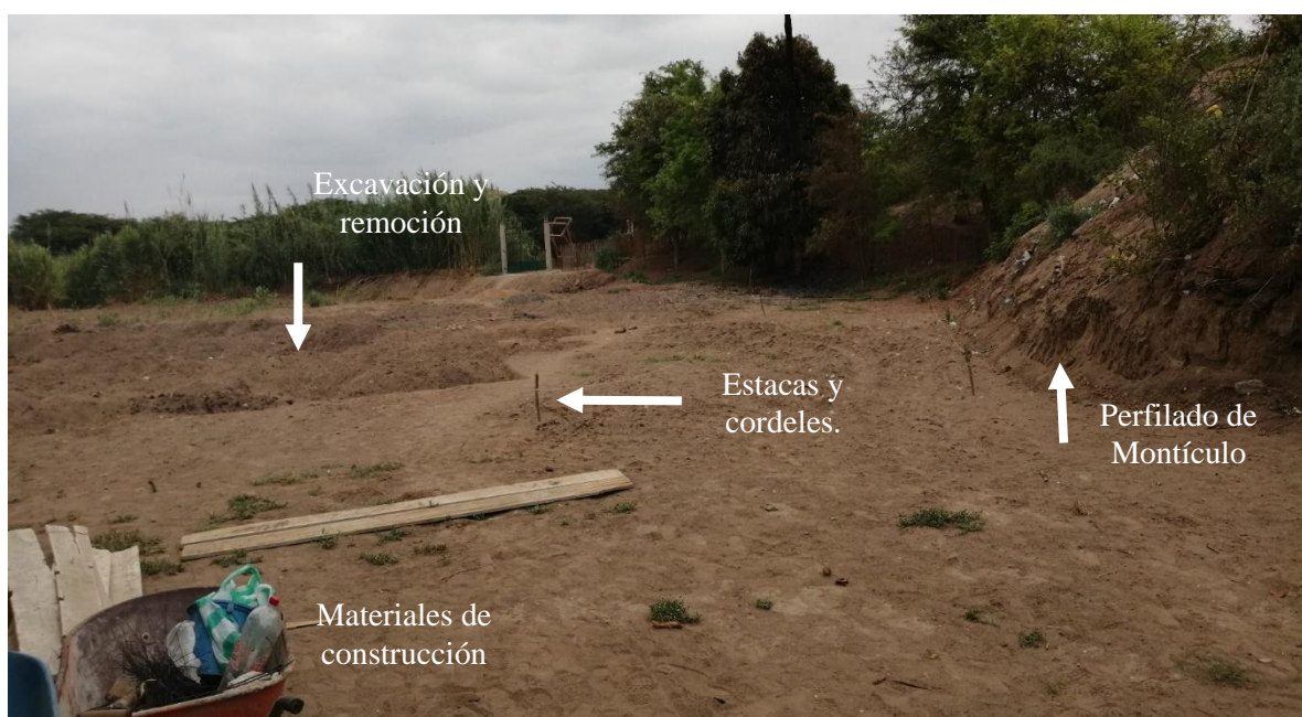
Imagen N°06: fotografía que muestra la remoción y excavación; además, se colocaron estacas y cordeles para nivelar el área. Se observa el perfilado de la ladera del montículo.
