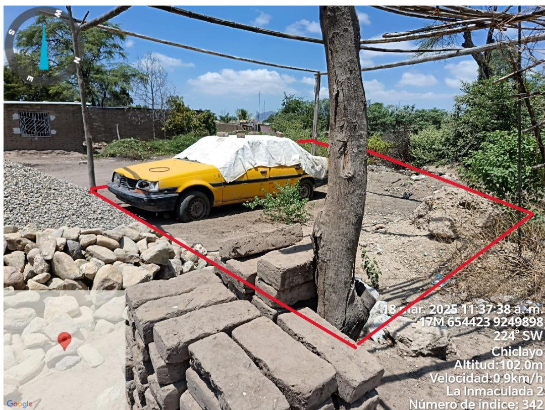
Imagen 6: Caso 5, Vista a detalle del área de afectación. Actualmente viene siendo utilizada como zona de estacionamiento y de almacenaje de material de construcción.
