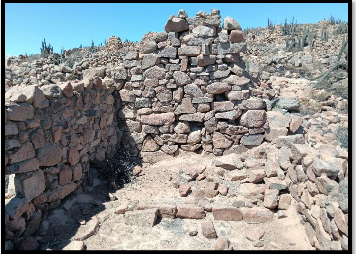
Foto N° 10: en el que se visualiza un recinto de planta rectangular en regular estado de conservación, visualizando ductos de ventilación.
