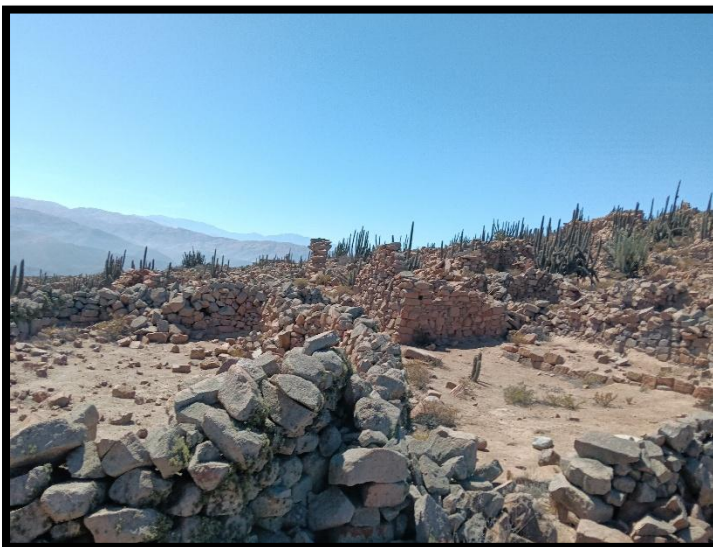
Foto N° 07: en el que se visualiza un conjunto de estructuras arquitectónicas en regular estado de conservación.
