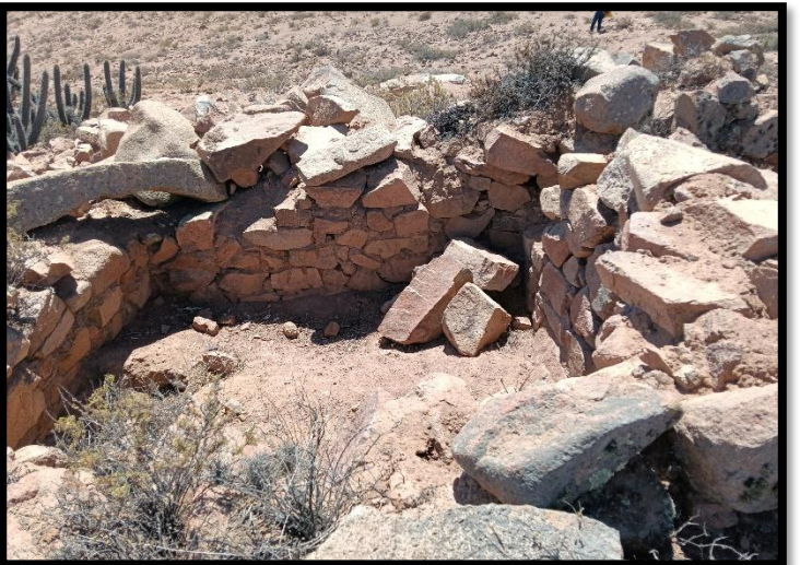
Foto N° 12: en el que se visualiza una estructura arquitectónica de planta rectangular el que se encuentra colapsada en sus 04 paramentos.
