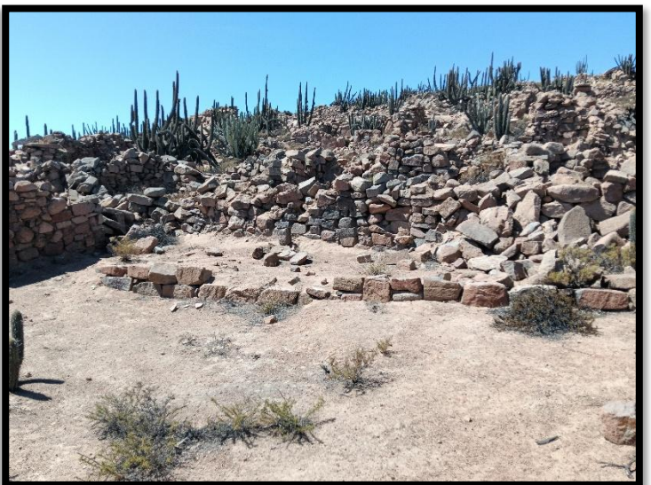
Foto N° 08: en el que se visualiza el conjunto de estructuras arquitectónicas de data prehispánica en el cual colapso algunos de sus elementos líticos.
