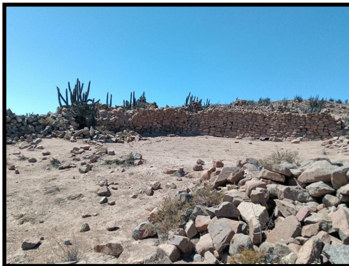
Foto N° 01: en el que se visualiza un recinto de planta rectangular en regular estado de conservación, registrando vegetación que se encuentra entre las juntas.
