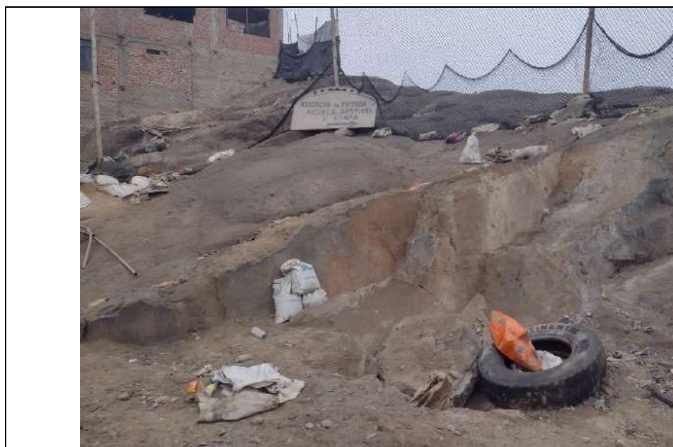
Lado Sur del área cercada. Detalle del afloramiento rocoso que está siendo canteado con barreta y con voladura de explosivos. Se observan costalillos rellenos con tierra y perforaciones para colocar explosivos (fotografía adjunta al Informe Técnico N° 0024-2024-DCS-DGDP-VMPCIC-CDT/MC que recoge la inspección de 02.06.2024)
