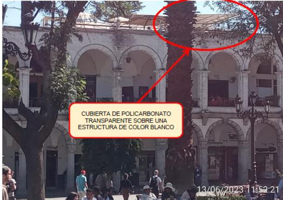
Imagen N° 1 – Estado del inmueble a junio del 2023
