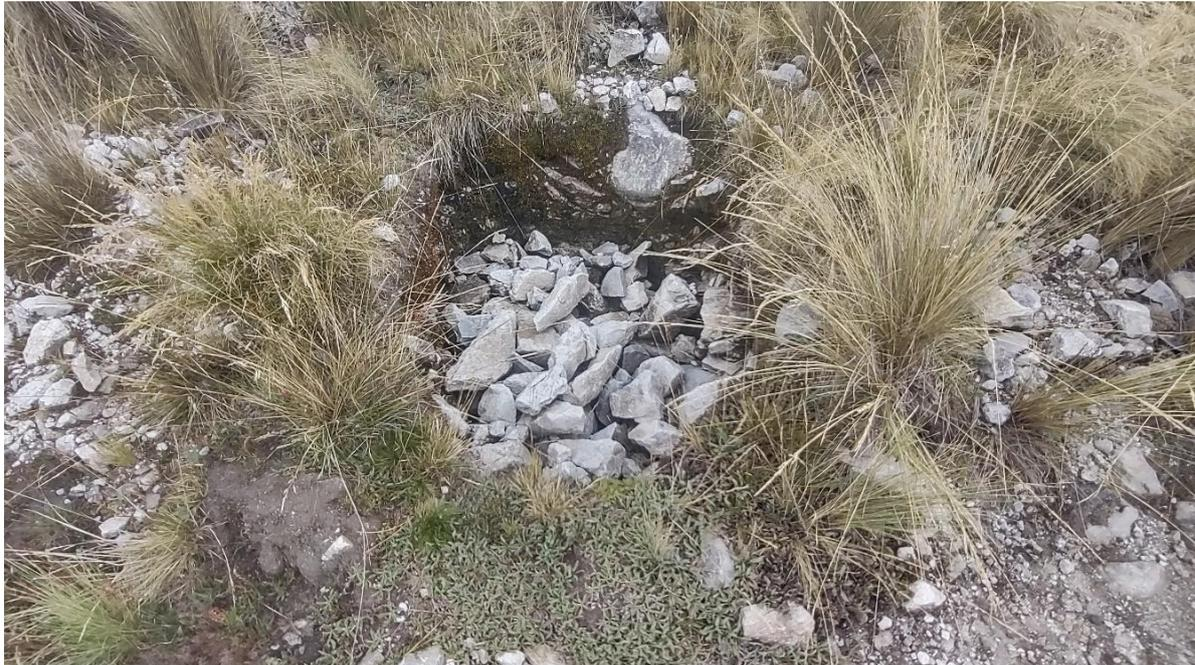
**Imagen 05.** Pozo excavado para la instalación de los postes de telecomunicación al interior de la poligonal arqueológica.
