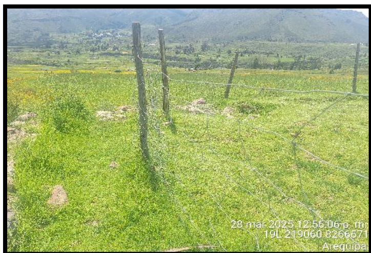
Foto N° 13: correspondiente al 28 de marzo del 2025, en el que se visualiza la instalación de un cerco perimétrico en áreas culturales.
