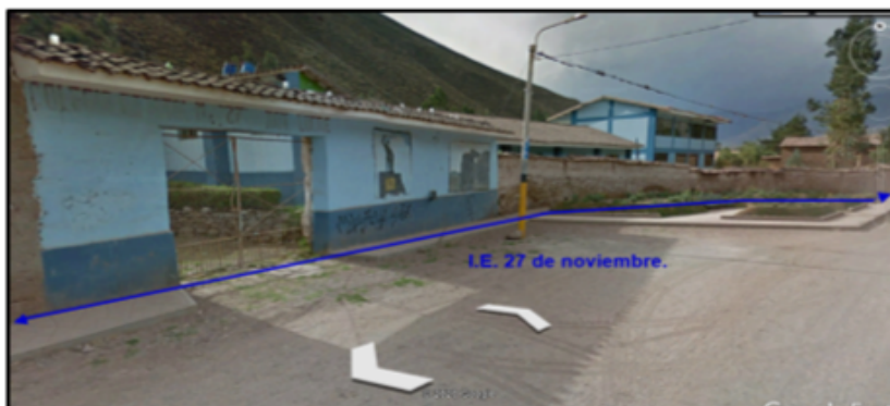
Vista fotográfica de la fachada de I.E. 27 de noviembre donde se visualiza parte de la infraestructura. Fuente- Imagen Google earth, agosto 2013.
