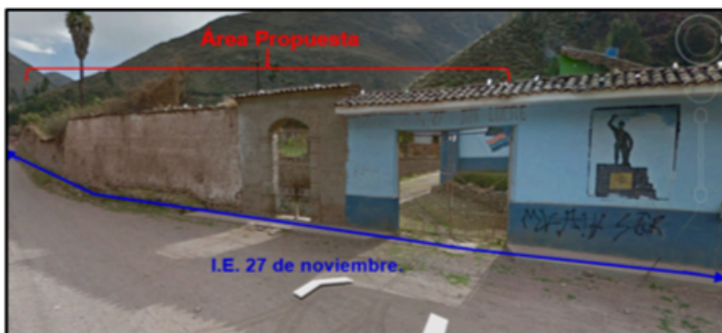
Vista fotográfica de la fachada de I.E. 27 de noviembre donde se visualiza el Área Propuesta correspondiente a la Antigua Hacienda Lircay. Fuente- Imagen Google earth, agosto 2013.
